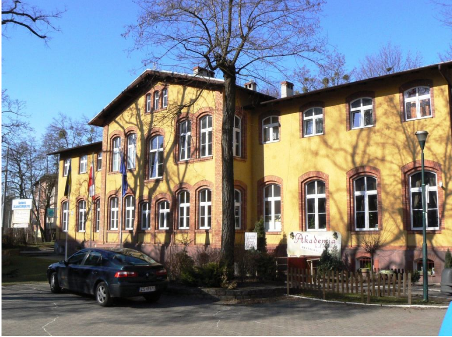
Budynek w Szczecinie należący do Związku Ukraińców w Polsce – siedziba oddziału i koła ZUWP (fot. autor)
