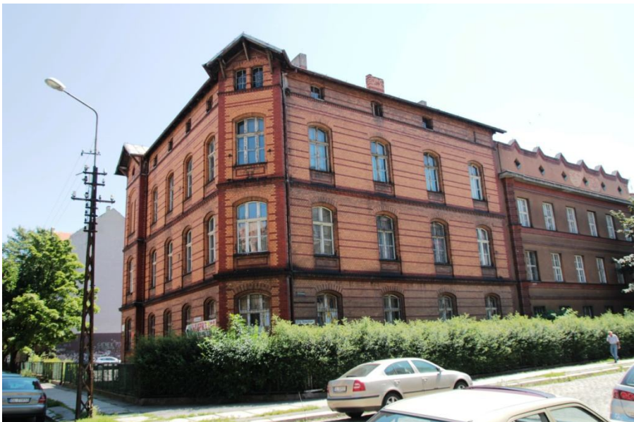
Budynek w Legnicy należący do Łemkowskiego Zespołu Pieśni i Tańca „Kyczer” – siedziba Zarządu Głównego Stowarzyszenia Łemków (fot. autor)
