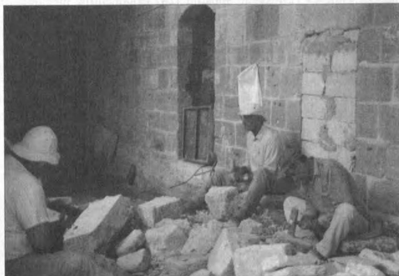
Ilustr. 4. Rzemieślnicy rekonstruują Khan w Sydonie posługując się różnie kalibrowaną gradzią. Fot. autorka, 2 października 1994
