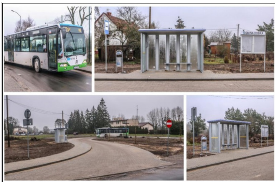
Rys. 6. Efekt inwestycji polegającej na remoncie pętli autobusowej w Kościnie
