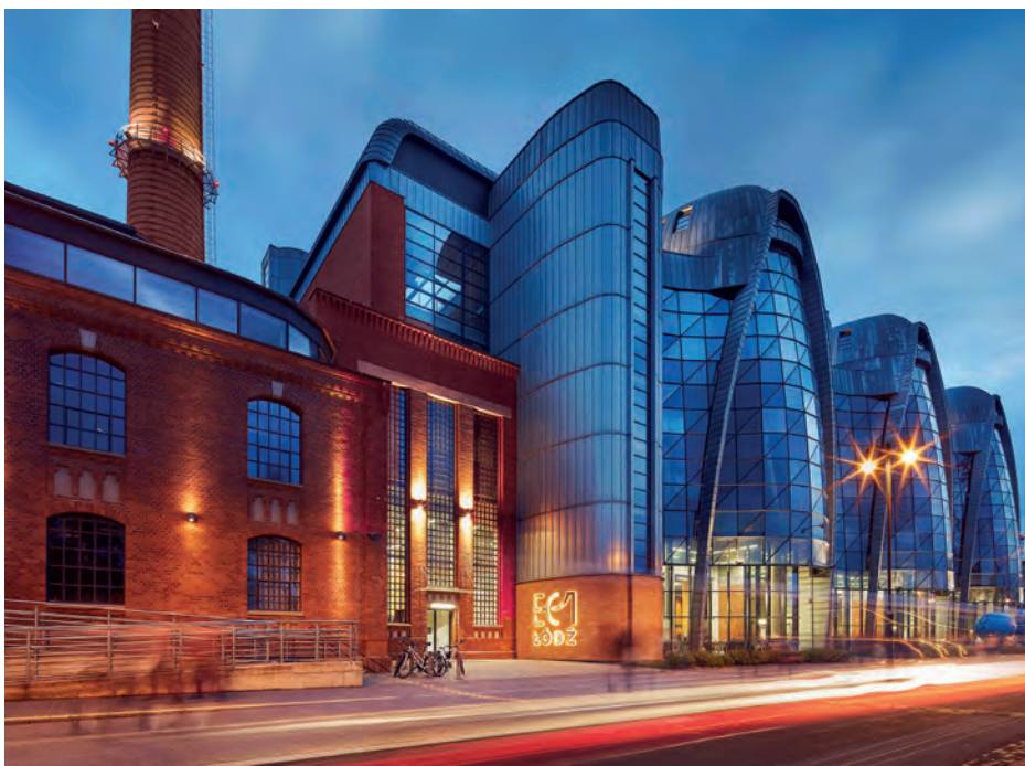
Rysunek 6. Zrewitalizowany budynek dawnej elektrowni EC1 Wschód (obecnie pełni funkcję centrum kultury i sztuki w Nowym Centrum Łodzi)
