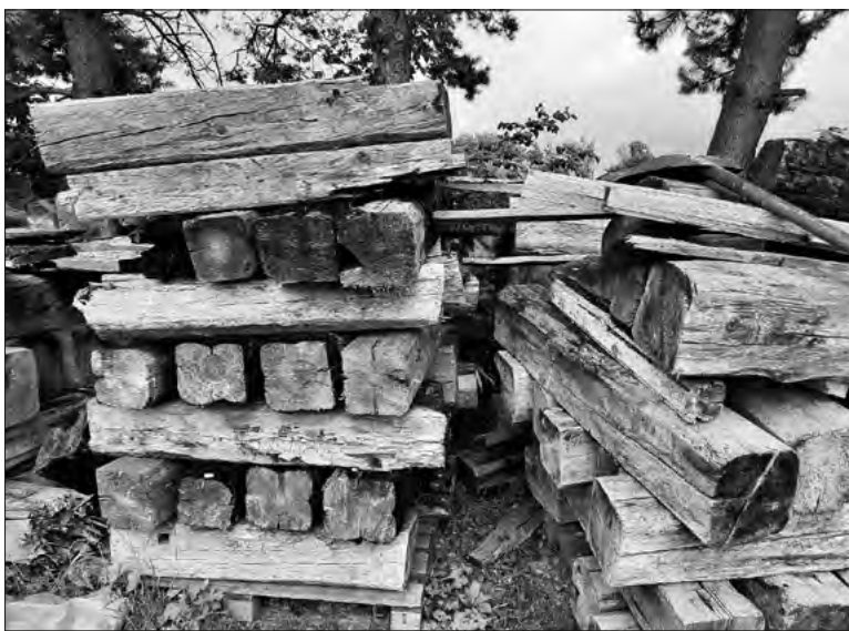
il. 25. Pozostałość dworu Rydlów w Dołuszcach. Fot. współczesna A.K.
