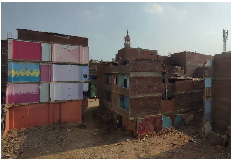
Rys. 2. Pozostałości bloków zburzonych podczas budowy trasy szybkiego ruchu w Gizie.
