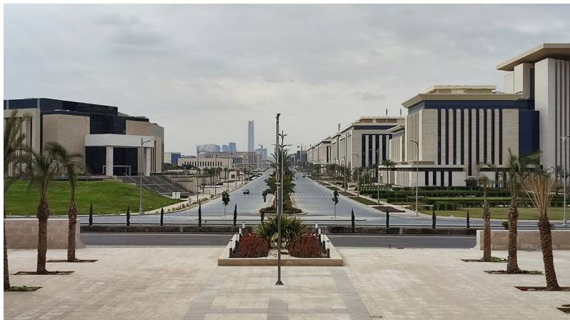
Rys. 3. Widok ogólny na rządową dzielnicę nowej stolicy.
