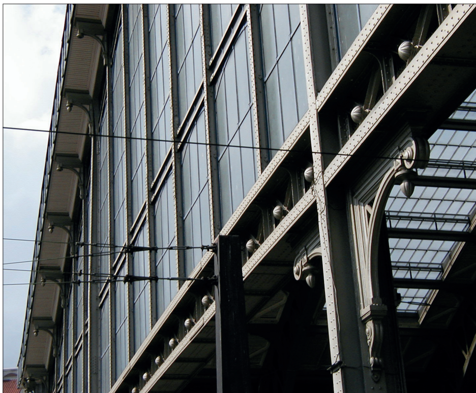
20. Lille-Flandres (1892), ściana wiatrowa hali peronowej dworca; fot. autora, 2001
