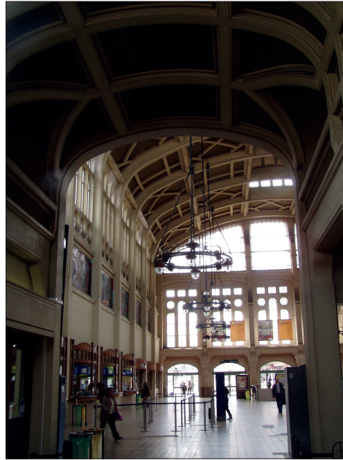
24. Żelbetowe sklepienia we wnętrzu dworca Rouen-Rive-Gauche (1928); fot. autor, 2011
