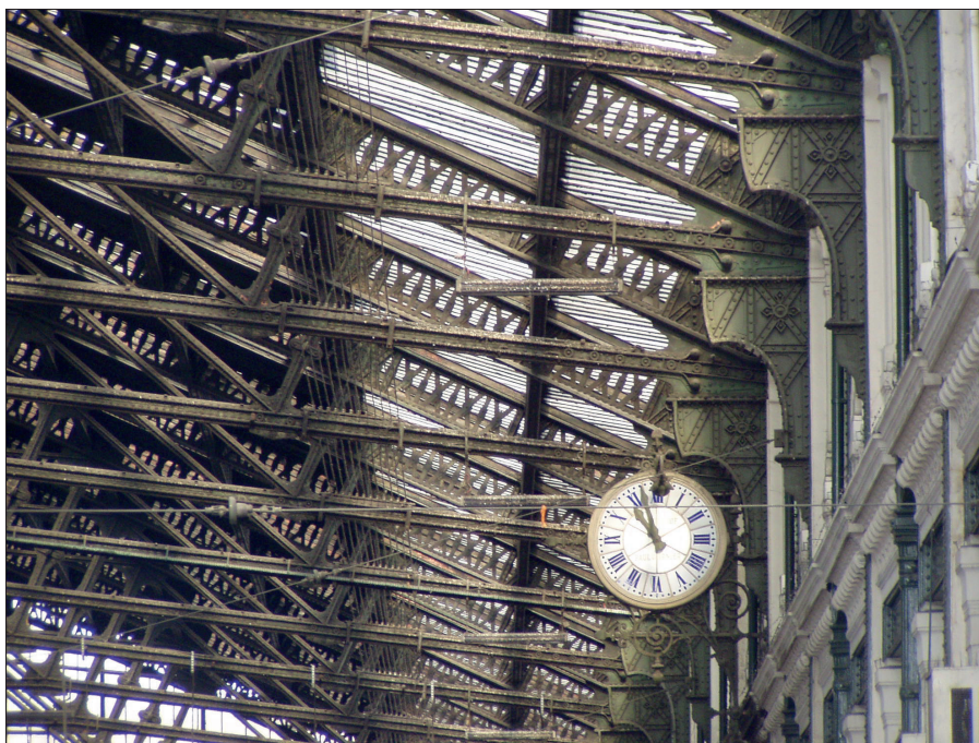
21. Dekoracje dźwigarów Polonceau: konsole w hali dworca Paris-Orléans (1868 – góra), konsole i słupki w hali dworca Paris-Lyon (1900 – dół); fot. autor, 2002, 2011
