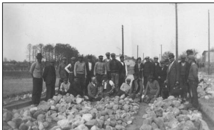
Ryc. 10: Budowa drogi (1. poł. XX w.)
