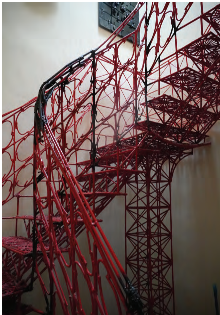
42. Schody kompozycja przestrzenna – funkcjonująca w domu-pracowni artysty w Łodzi, 2010–2012, konstrukcja przestrzenna spełniająca funkcję schodów wykonana poprzez spawanie prętów 6 mm, 8 mm, 10 mm, 12 mm Fot. Aneta Pawłowska
