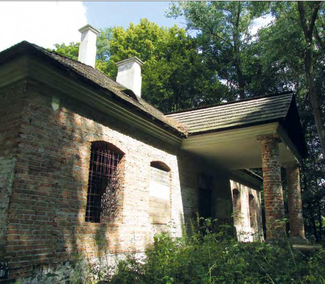
6. Bieliny, dawny dwór Mniszchów, elewacja frontowa, fot. Alina Barczyk, 2016
