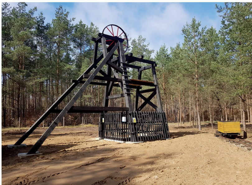
Rekonstrukcja szybu i wieży drewnianej w dawnej kopalni Buko.
