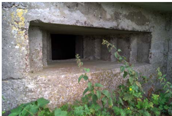
Fot. 5. Otwór strzelniczy w tradytorku jednostronnym usytuowanym w Stronówku Photo 5. Embrasure in a one-sided casemate located in Stronk
