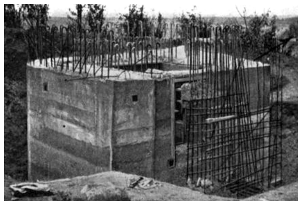
Fot. 2. Schron przed zalaniem stropu i przelotni. Źródło: Denkschrift über die polnische Landesbefestigung , Berlin 1941, str. 238–239, http://www.mapywig.org/m_documents/DE/Denkschrift_ueber_die_polnische_Landesbefestigung_1941.pdf , dostęp: 8.03.2017
