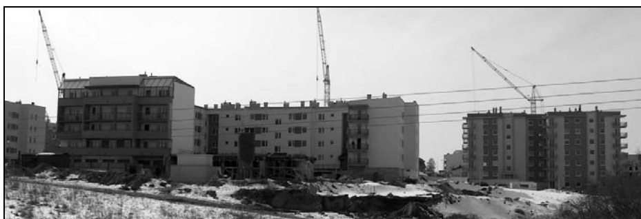
Fot. 6. Budowa osiedla Botanik (fot. D. Kociuba)
