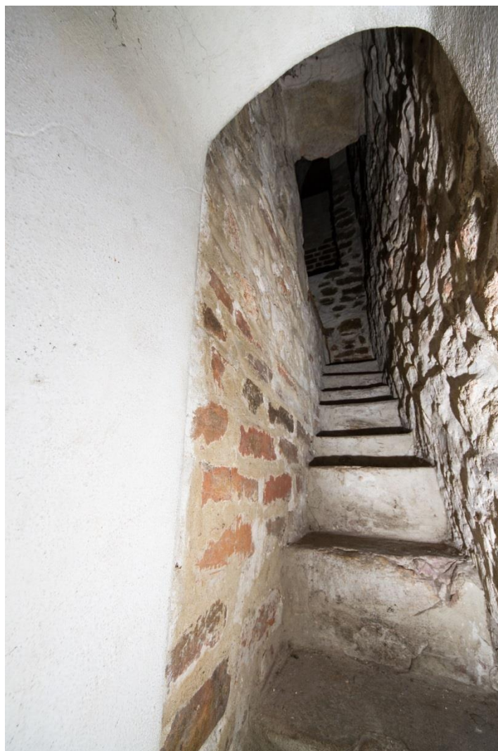
Ryc. 95 - Sulejów. Klatka schodowa nr 1. Widok w górę z poziomu badanego piętra
