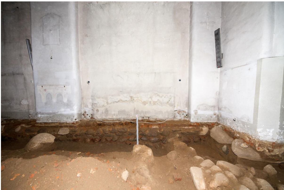
Ryc. 139 - Biała Rawska. Fundament północnej ściany nawy na styku ze ścianą łuku tęczowego. Fot. A. Ginter
