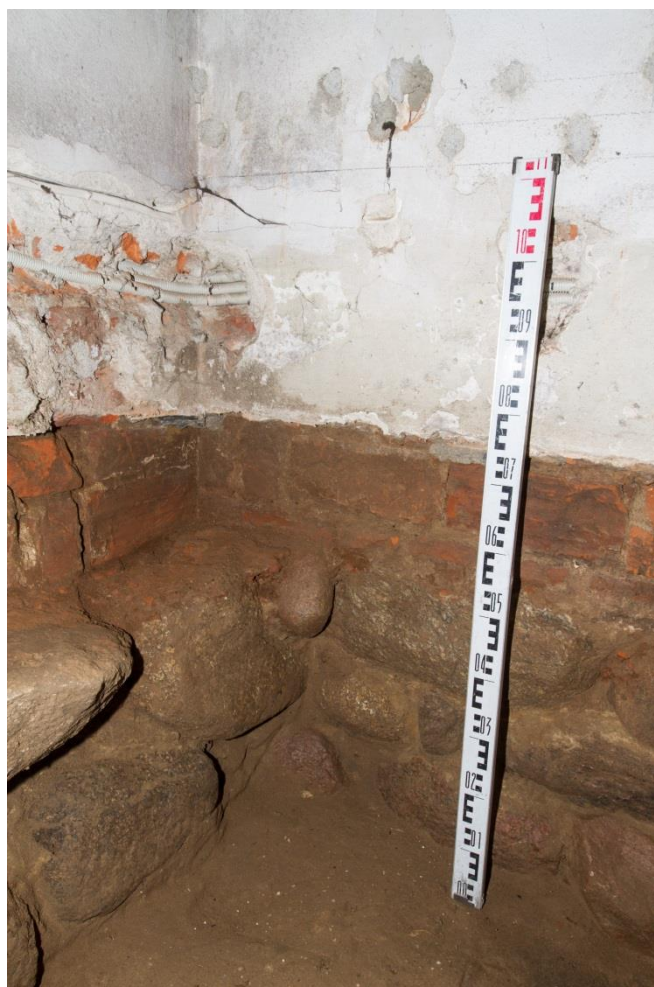
Ryc. 143 - Biała Rawska. Północna ściana prezbiterium na styku ze ścianą tęczową. Fot. A. Ginter
