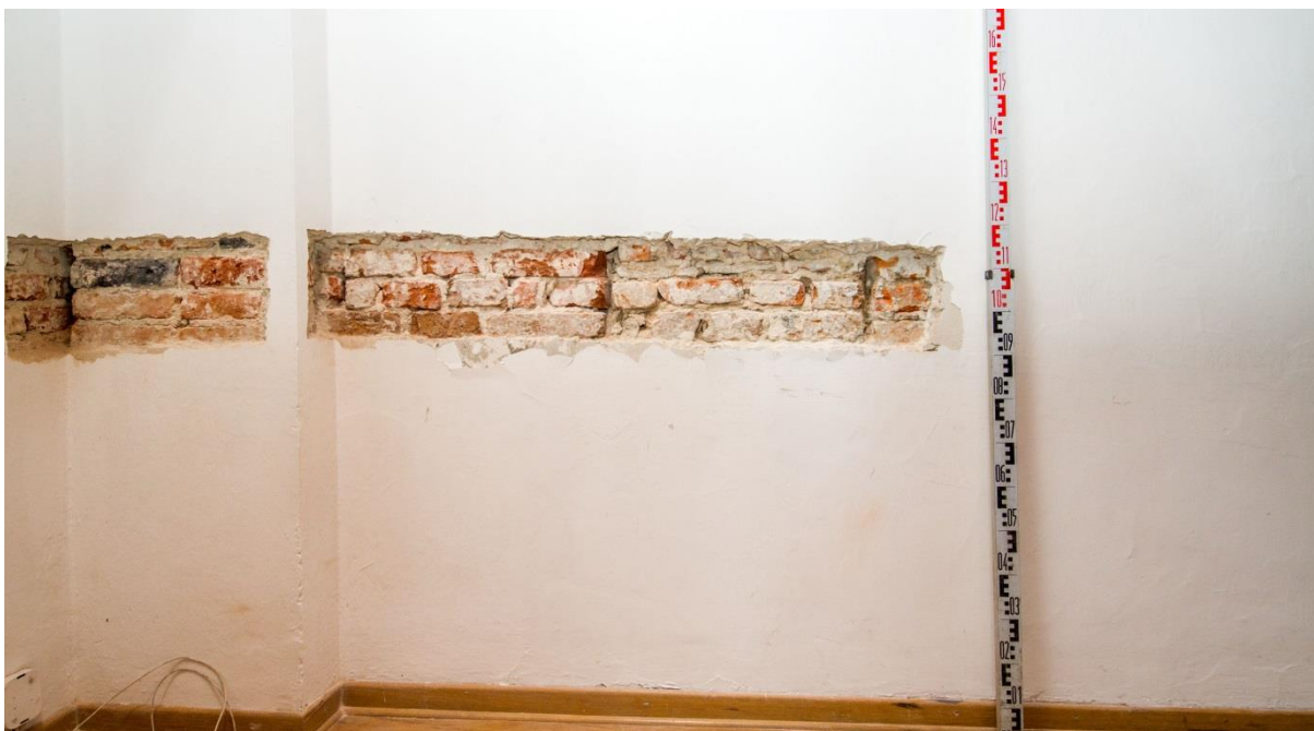
Ryc. 101 - Sulejów. Pomieszczenie 108 – w centrum odkrywka 08. Odsłonięte relikty otworu okiennego lub komunikacyjnego w południowej ścianie pomieszczenia
