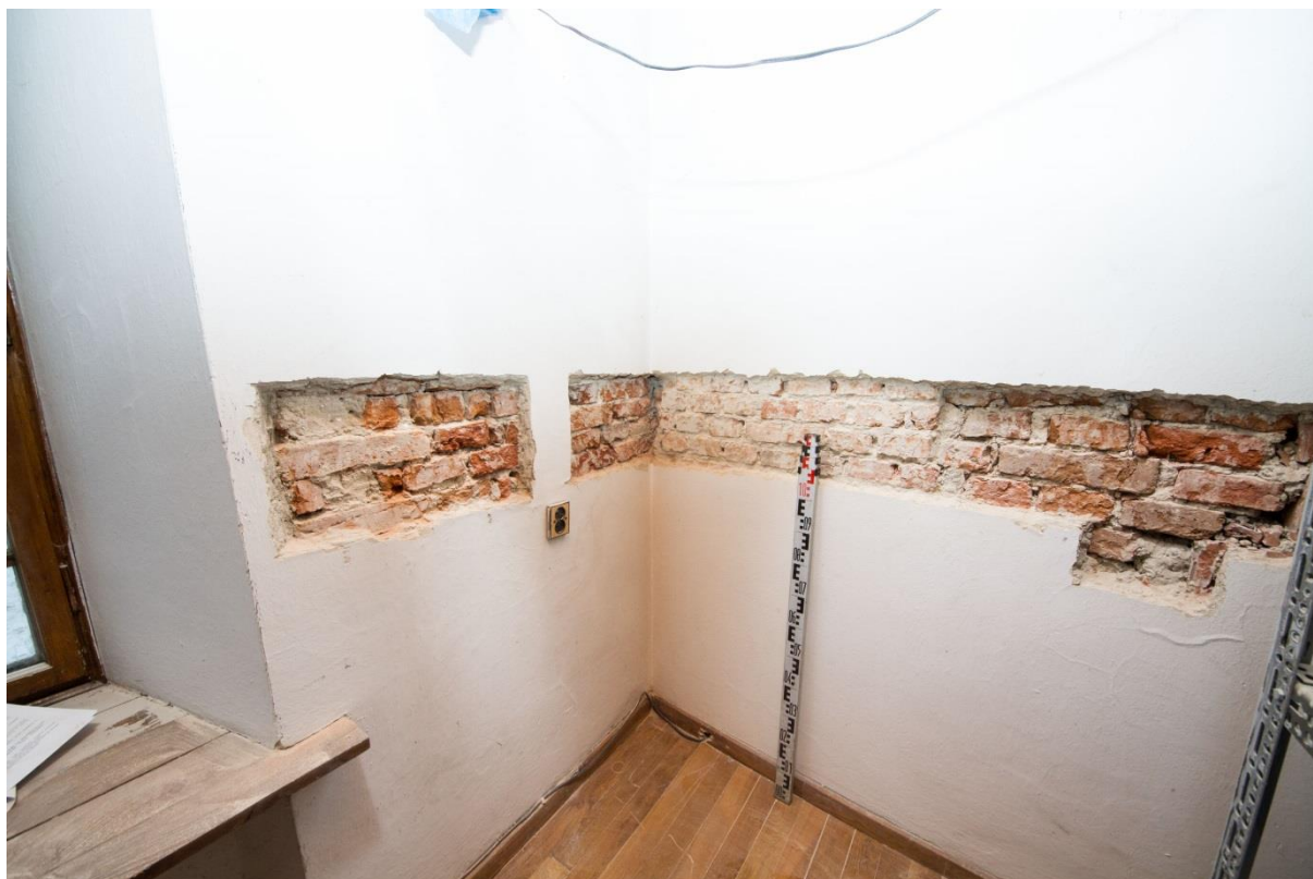
Ryc. 105 - Sulejów. Pomieszczenie 109 - odkrywki 02 i 03. Łata usytuowana w miejscu zamurowanego otworu komunikacyjnego
