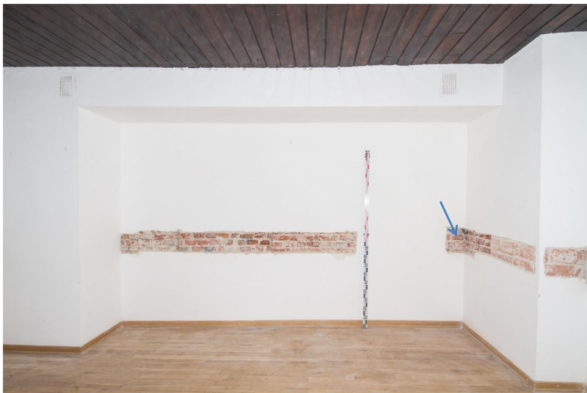
Ryc. 124 - Sulejów. Pomieszczenie 110 - ściana północna. Strzałką zaznaczono lokalizację próbki nr 9
