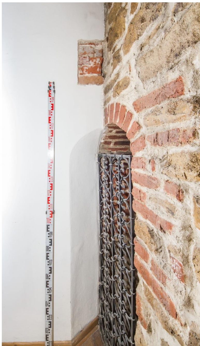
Ryc. 103 - Sulejów. Pomieszczenie 108 - odkrywka 10. Widoczne dostawienie ceglanej ściany do kamiennego lica baszty attykowej
