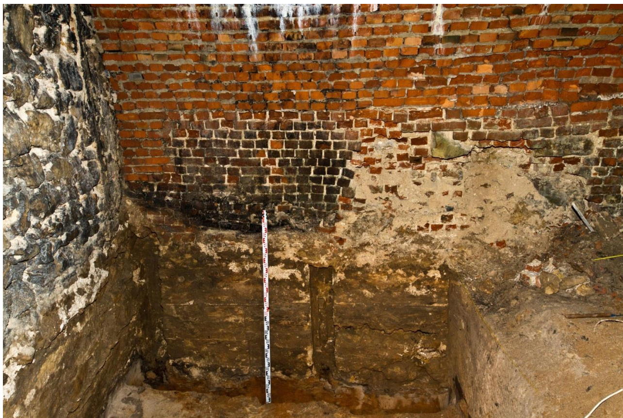
Ryc. 28 - Siewierz. Wschodnia ściana pomieszczenia. Końcówka łąty wskazuje na zachowany fragment nowożytnego sklepienia Fot. A. Ginter
