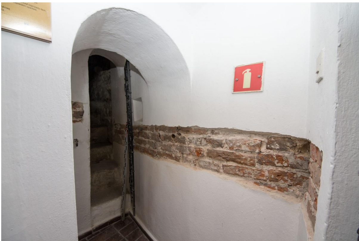
Ryc. 93 - Sulejów. Pomieszczenie 106 – odkrywka 04
