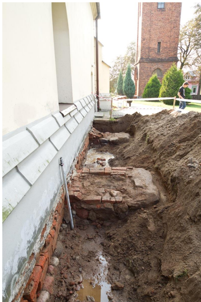
Ryc. 136 - Biała Rawska. Północna ściana zakrystii. Widoczne relikty dwóch przypór. Fot. A. Ginter
