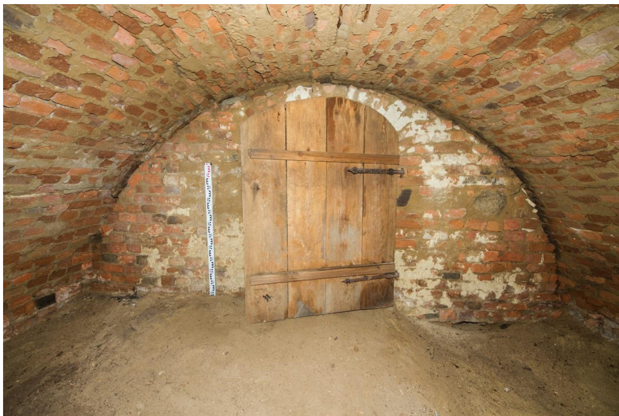
Ryc. 168 - Biała Rawska. Krypta numer 4 - północna ściana pomieszczenia. Fot. A. Ginter
