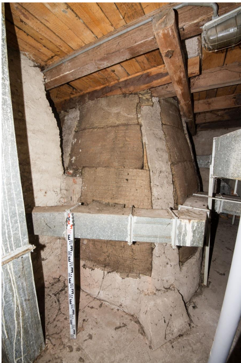
Ryc. 111 - Sulejów. Pomieszczenie 202 – widok na komin od strony zewnętrznej
