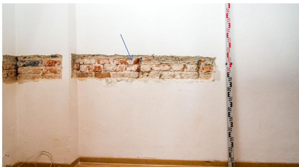
Ryc. 120 - Sulejów. Pomieszczenie 108 – ściana południowa. Strzałką zaznaczono lokalizację próbki nr 4
