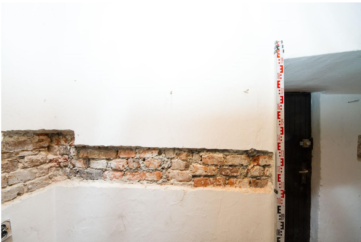
Ryc. 106 - Sulejów. Pomieszczenie 109 - po lewej stronie w narożniku fragment skutej ściany będącej być może pierwotnym podziałem pomieszczenia, na wprost zamurowane przewody kominowe
