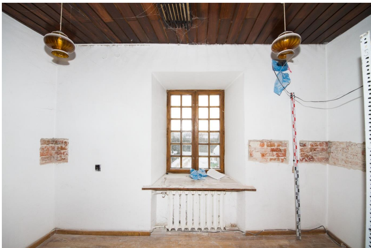
Ryc. 125 - Sulejów. Pomieszczenie 109 - ściana południowa. Strzałką zaznaczono lokalizację próbki nr 10
