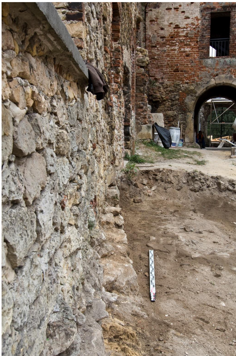
Ryc. 16 – Siewierz. Odsłonięta korona fundamentu zachodniego budynku o metryce średniowiecznej. Fot. A. Ginter
