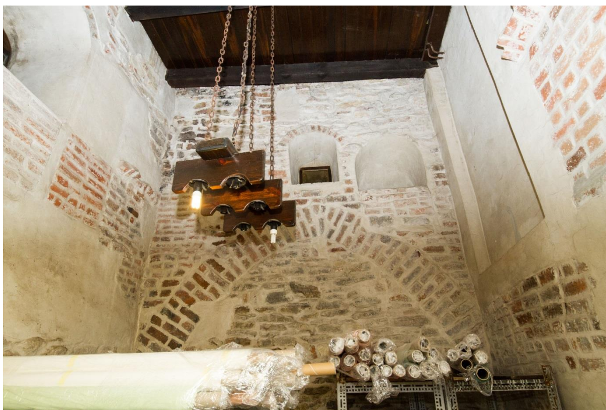
Ryc. 112 - Sulejów. Pomieszczenie 001 – ściana północna
