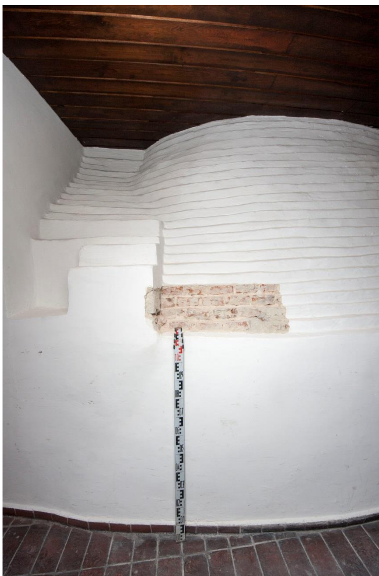
Ryc. 88 - Sulejów. Pomieszczenie 103 - lico komina wraz z odkrywką architektoniczną 01
