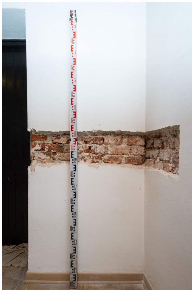
Ryc. 107 - Sulejów. Pomieszczenie 110 – odkrywka 01. Widoczne dostawienie ściany działowej do południowej ściany magistralnej budynku
