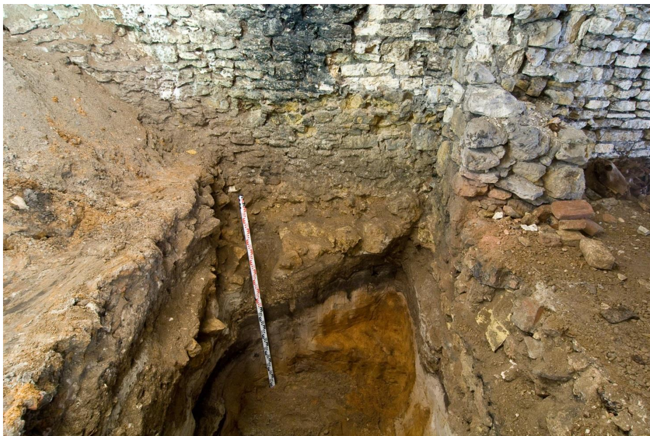
Ryc. 19 – Siewierz. Piwnica zachodnia – wykop 2. Relikty zachowanej średniowiecznej ściany kurtynowej zamku we wnętrzu piwnicy zachodniego skrzydła. Fot. A. Ginter
