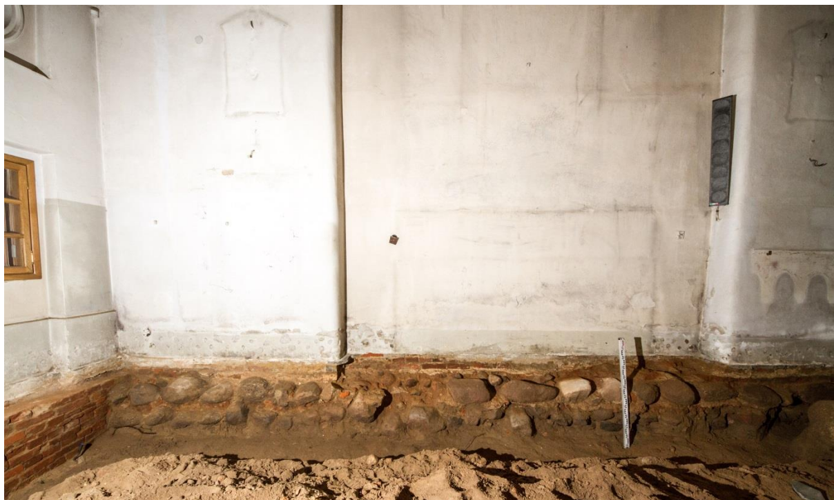
Ryc. 138 - Biała Rawska. Odsłonięty fundament północnej ściany nawy na styku z dostawionym ceglany fundamentem fasady. Fot. A. Ginter
