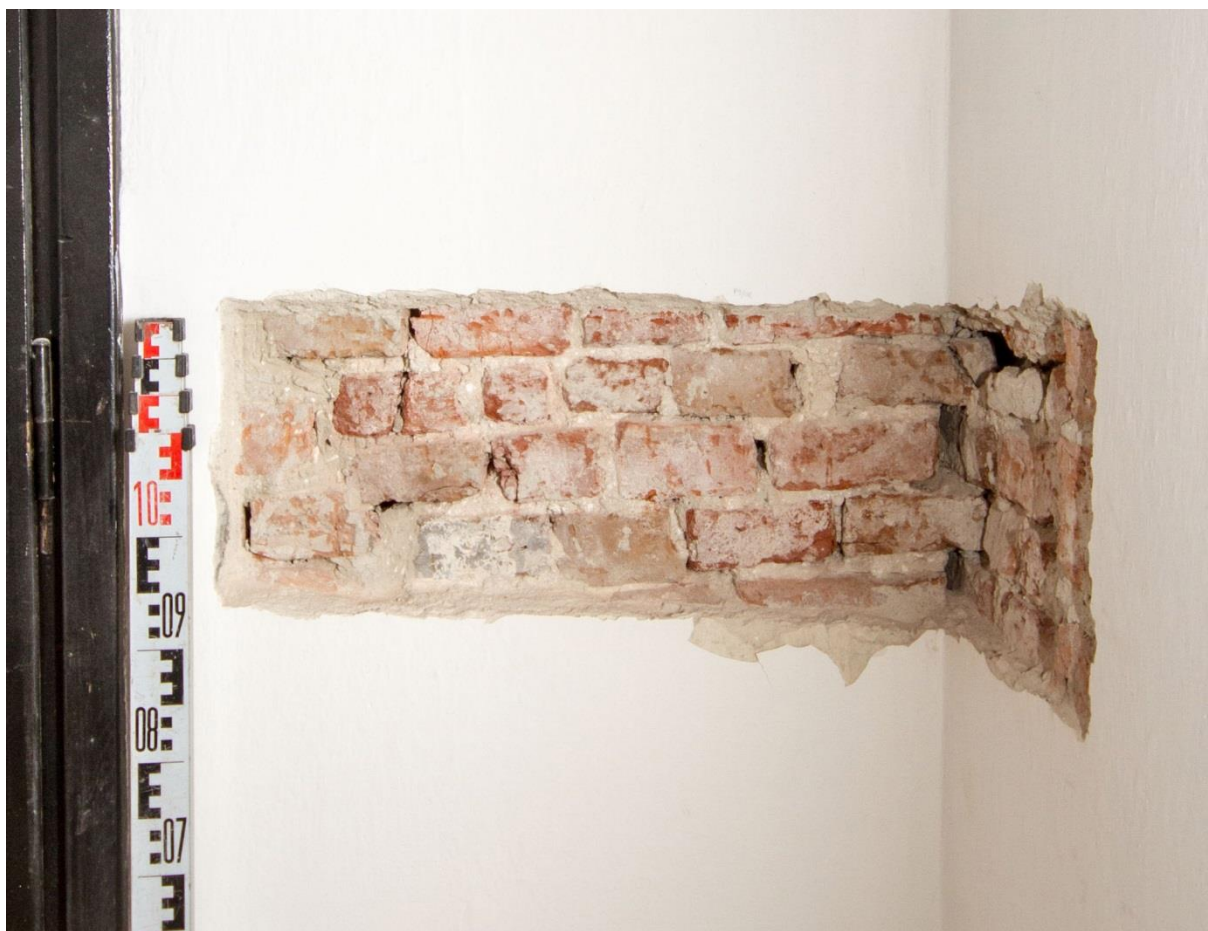
Ryc. 109 - Sulejów. Pomieszczenie 111 –odkrywka 02. Widoczna próba wymuszenia wiązania
