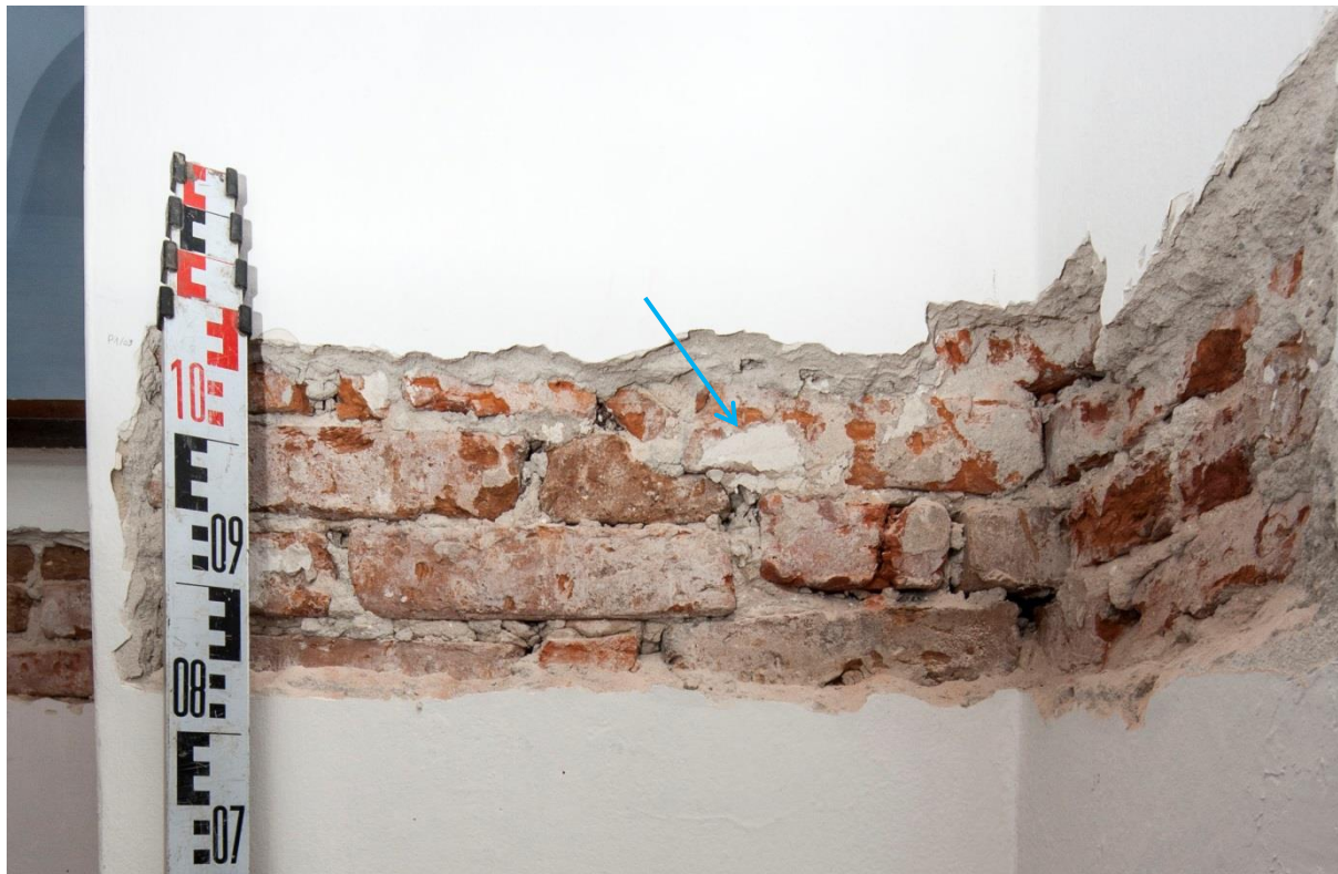
Ryc. 90 - Sulejów. Pomieszczenie 103 - odkrywka 03. Strzałką zaznaczone pozostałości pobiałej cegiel
