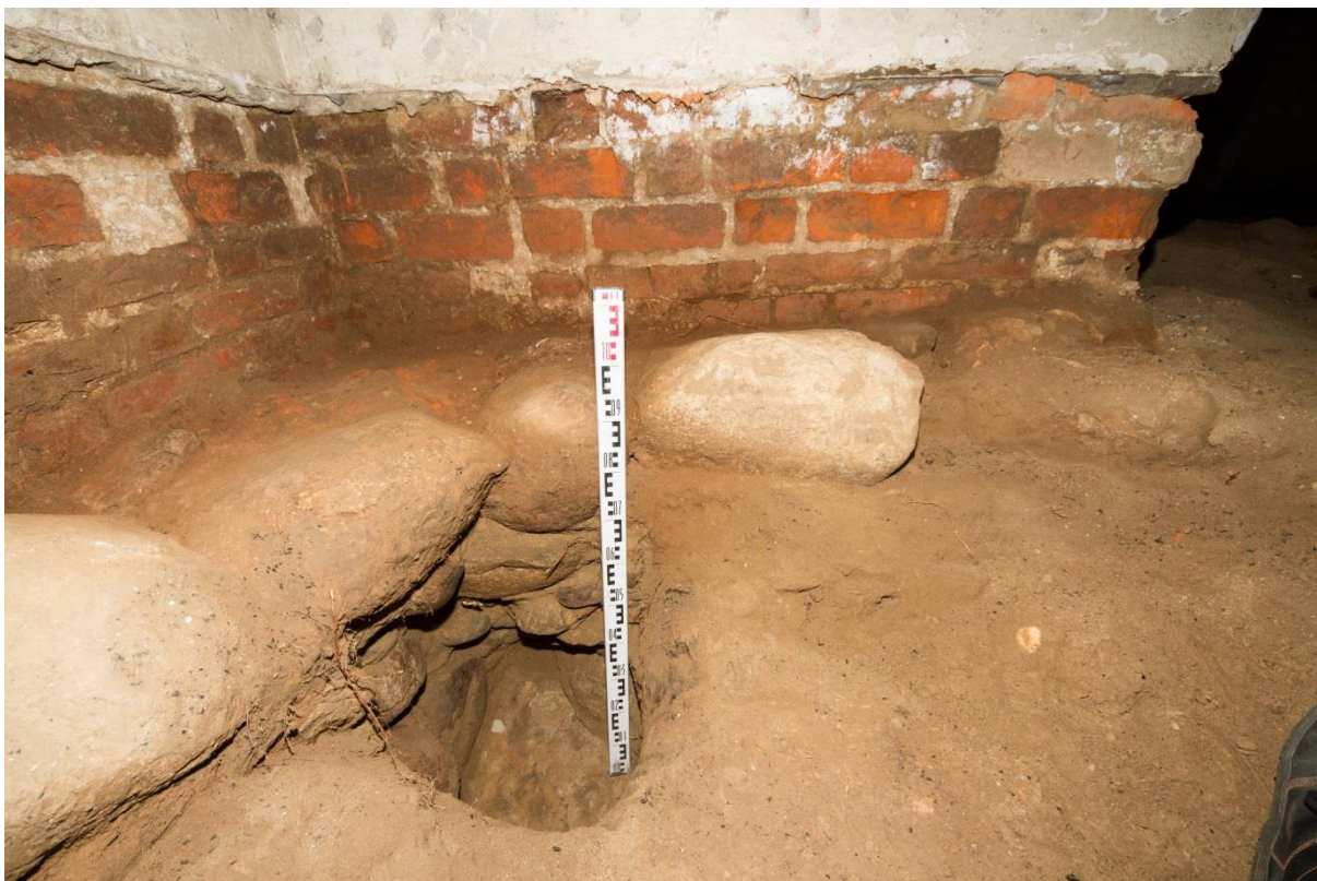
Ryc. 145 - Biała Rawska. Sondaż w narożniku ściany południowej prezbiterium i ściany tęczowej potwierdzający przewiązanie obydwu konstrukcji. Fot. A. Ginter
