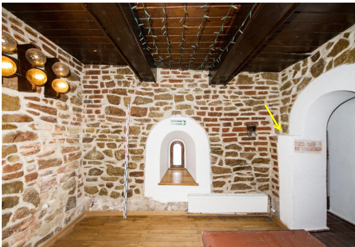
Ryc. 98 - Sulejów. Pomieszczenie 107 - wnętrze baszty attykowej. Okno z widokiem w kierunku północnym, otwór po prawej stronie prowadzi do pomieszczenia 106. Strzałką zaznaczona odsadzka na wschodniej ścianie baszty
