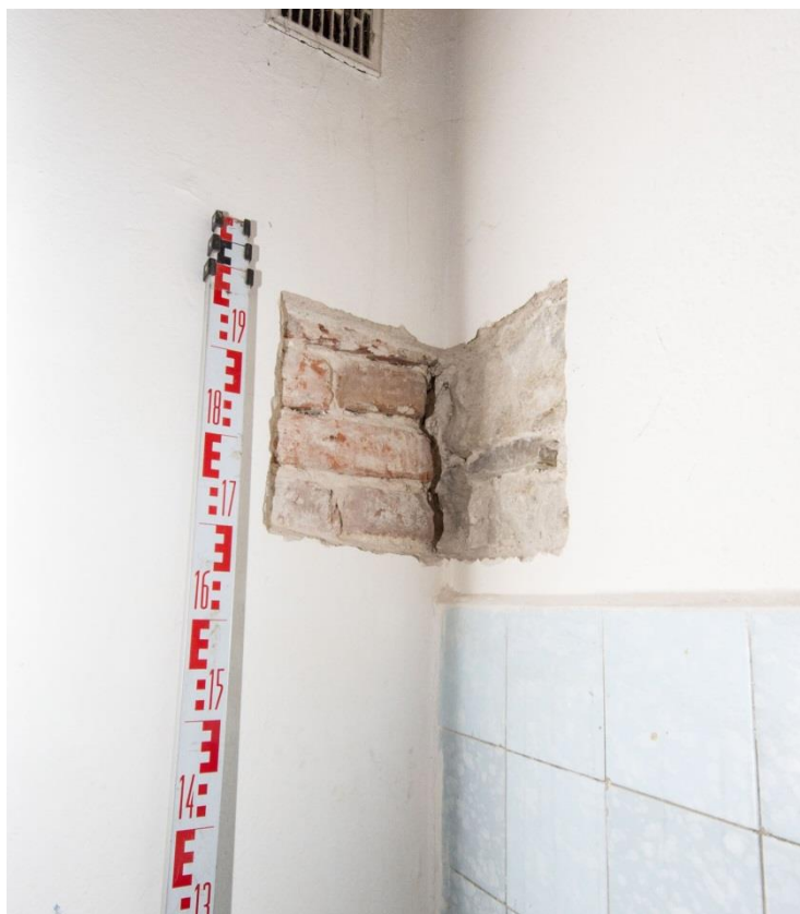
Ryc. 91 - Sulejów. Pomieszczenie 105. W węźle wyraźny styk ściany kamiennej z ceglana
