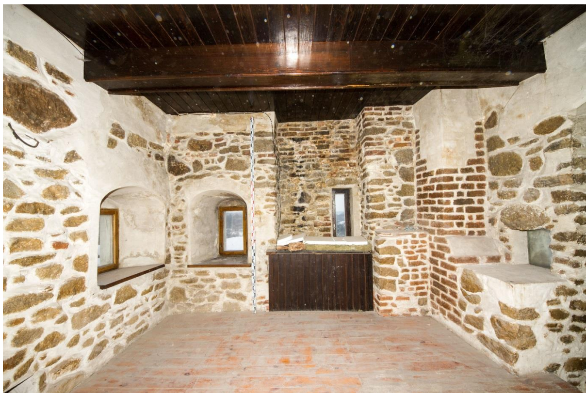
Ryc. 110 - Sulejów. Pomieszczenie 201 – ściana zachodnia
