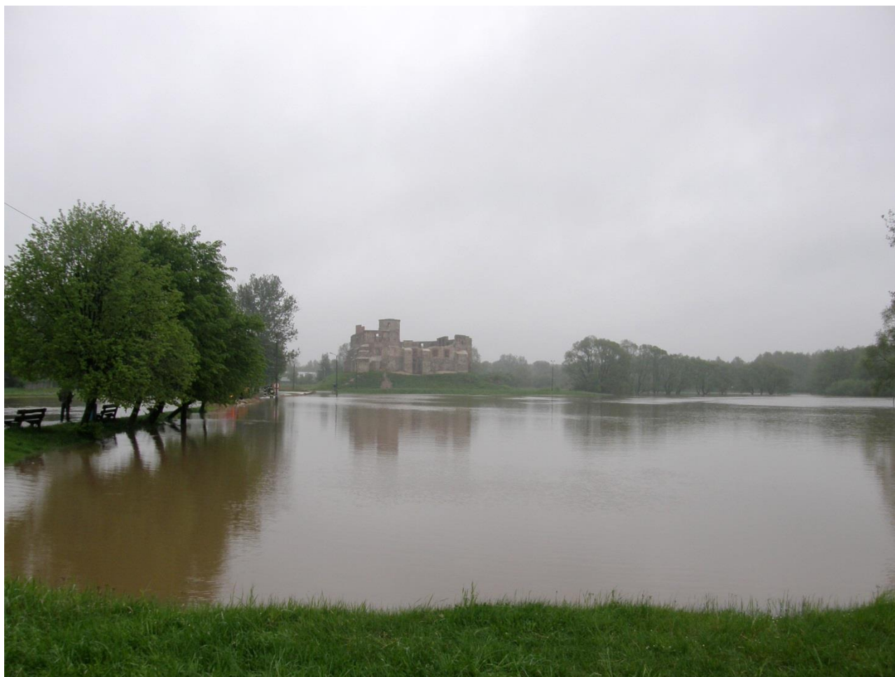
Ryc. 7 - Zamek w Siewierzu. Zdjęcie wykonane w maju 2010 r. od strony południowej. W wyniku ulewnych deszczów „powróciło” jezioro otaczające przez wieki całe założenie. Fot. A. Rok
