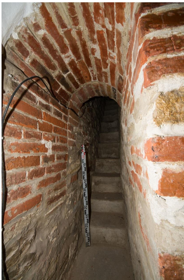
Ryc. 104 - Sulejów. Pomieszczenie 108 - wejście na klatkę schodową nr 3 prowadzącą do baszty attykowej
