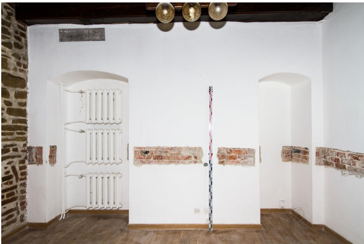
Ryc. 100 - Sulejów. Odkrywki na wschodniej ścianie pomieszczenia. W prawej części zdjęcia być może relikty zamurowanego przejścia między pomieszczeniami
