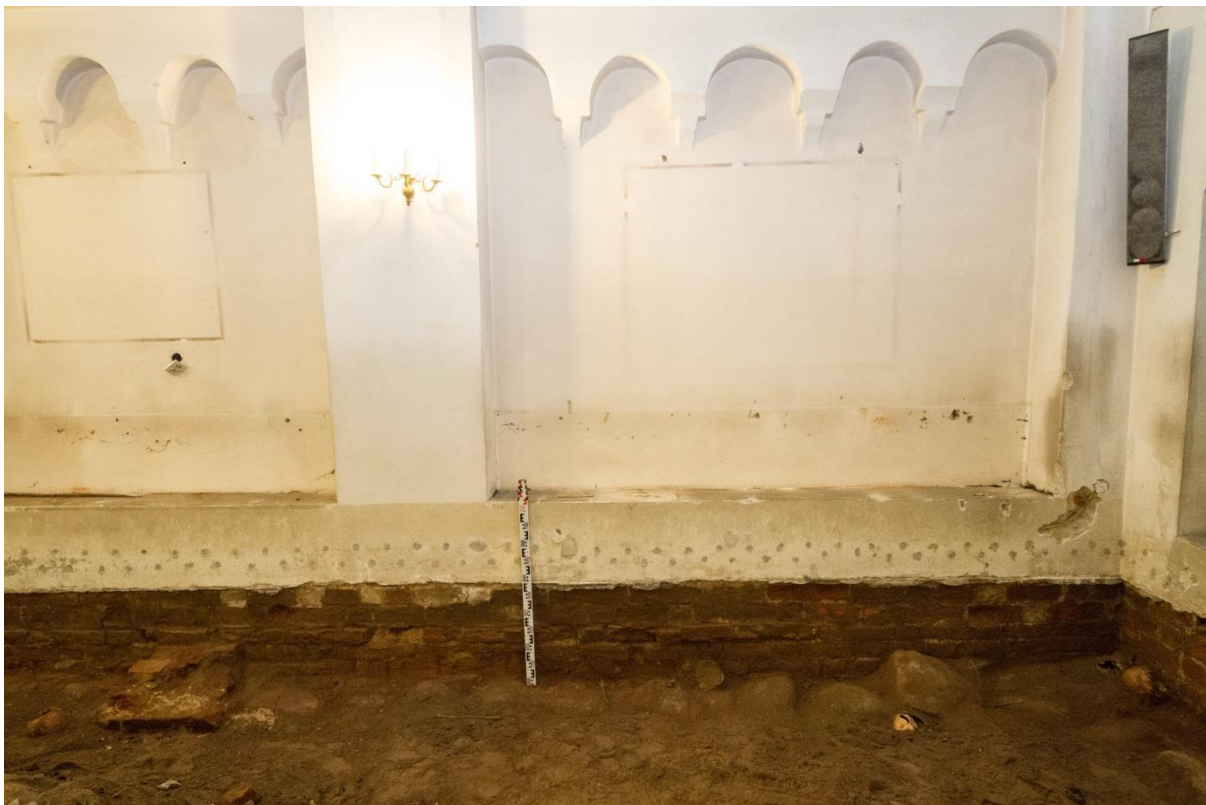
Ryc. 144 - Biała Rawska. Południowa ściana kościoła na styku ze ścianą tęczową. Fot. A. Ginter
