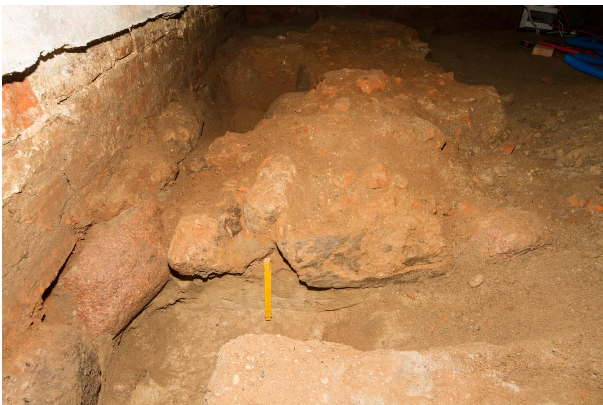
Ryc. 148 - Biała Rawska. Niewielki sondaż przy fundamencie odsłoniętym w zakrystii w celu uchwycenia poziomu jego posadowienia. Fot. A. Ginter
