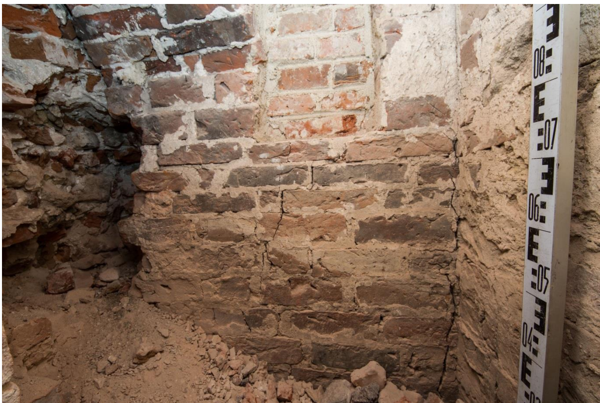
Ryc. 97 - Sulejów. Klatka schodowa nr 2 - zdjęcie z poziomu załamania biegu schodów. Po lewej stronie zdjęcia ściana gorzelni zamykająca światło rozebranej w tym miejscu klatki w trakcie nowożytnych prac budowlanych
