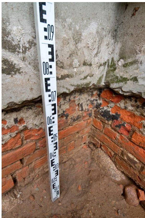
Ryc. 135 - Biała Rawska. Narożnik północnej ściany kościoła ze wschodnią ścianą zakrystii. Fot. A. Ginter
