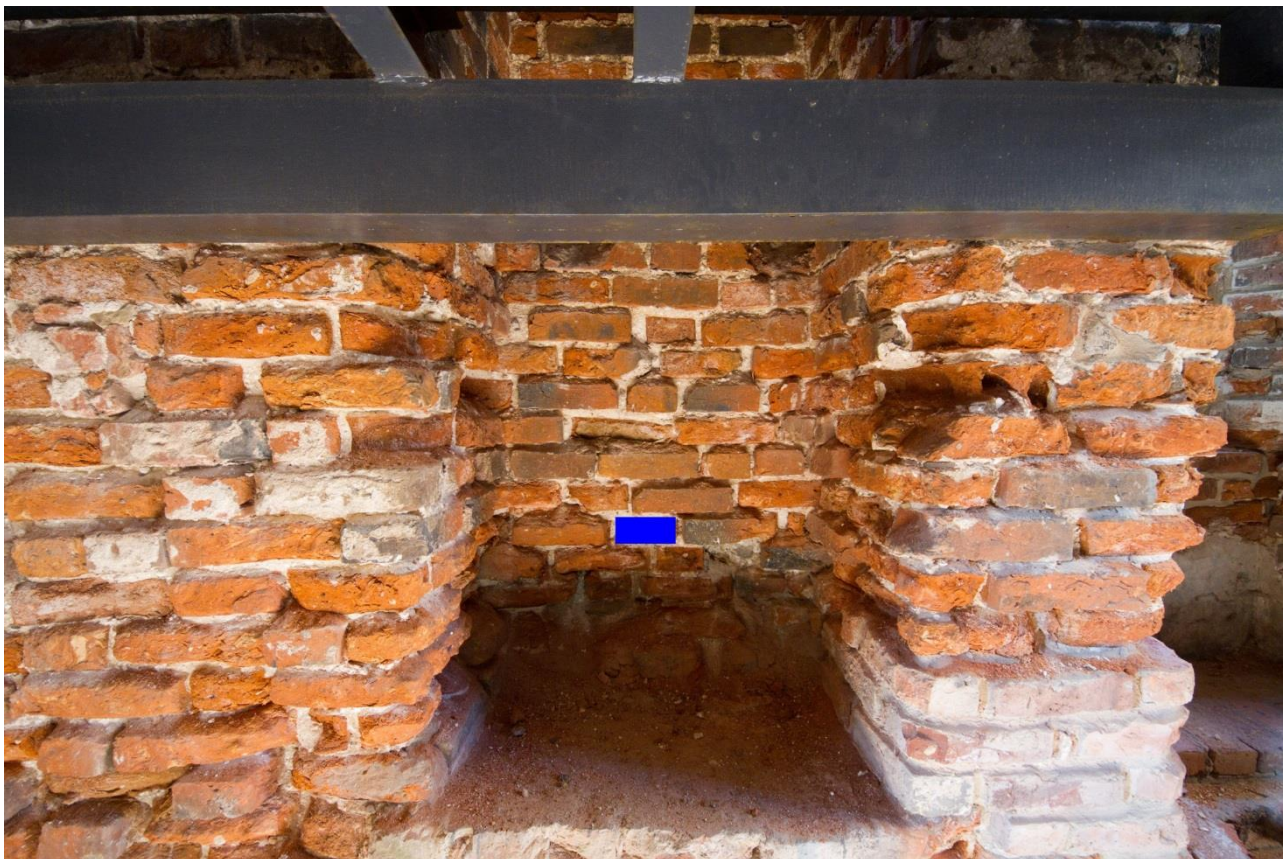
Ryc. 75 - Siewierz. Ściana zachodnia wieży bramnej - wnętrza. Na niebiesko miejsce pobrania próby do badań TL. Fot. A. Ginter
