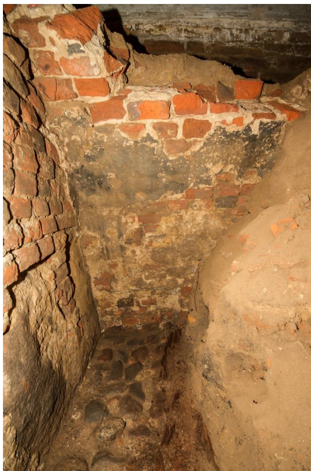
Ryc. 167 - Biała Rawska. Krypta numer 3 - widoczne malowanie tynku oraz kamienna posadzka z zachowanymi na niej dranicami. Fot. A. Ginter
