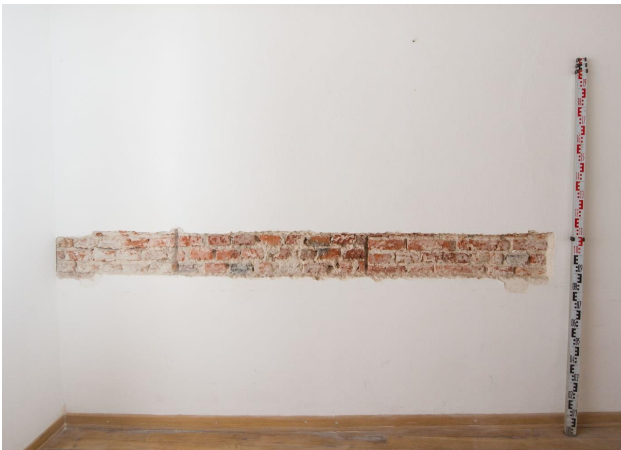
Ryc. 108 - Sulejów. Pomieszczenie 110 - odkuwka 04. W centrum widoczny zamurowany otwór komunikacyjny do pomieszczenia 104
