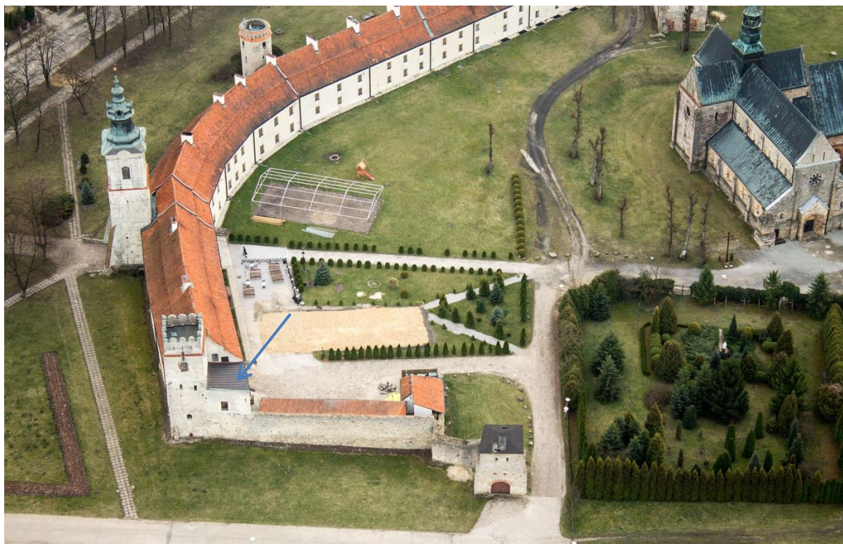
Ryc. 121 - Sulejów. Zdjęcie lotnicze północnej części zabudowań klasztornych. Strzałką zaznaczono lokalizację pomieszczenia 108
