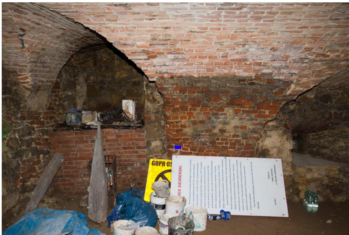
Ryc. 70 - Siewierz. Najniższa kondygnacja bastei. Na niebiesko zaznaczone miejsce pobrania próby do badań TL. Fot. A. Ginter
