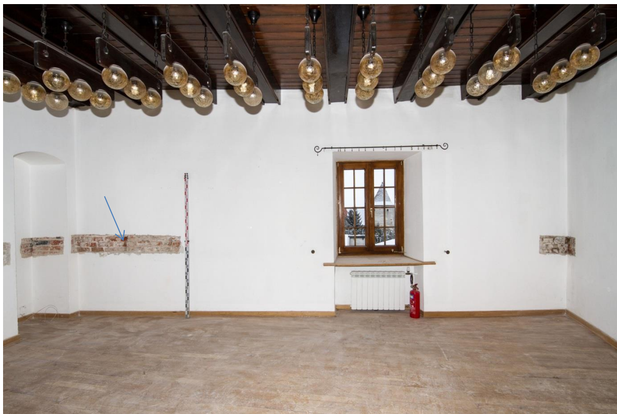
Ryc. 119 - Sulejów. Pomieszczenie 108 – ściana południowa. Strzałką zaznaczono lokalizację próbki nr 4
