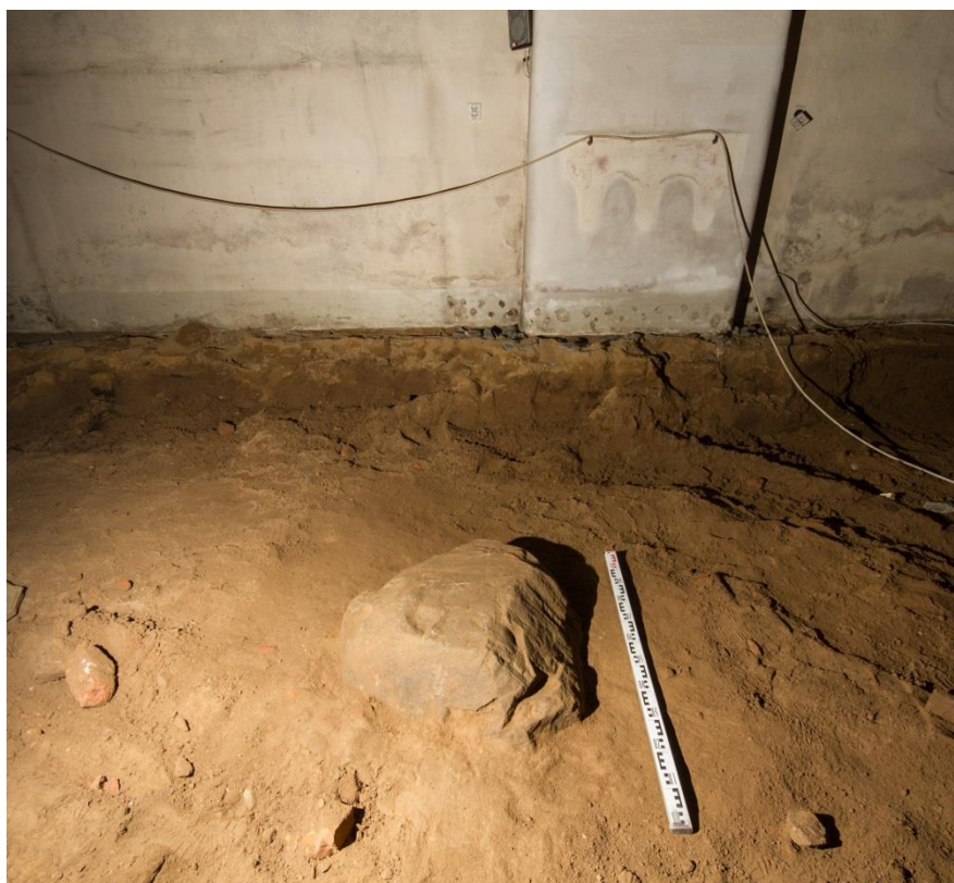
Ryc. 158 - Biała Rawska. Fundament nr 4 wykonany z jednego dużego kamienia. Fot. A. Ginter
