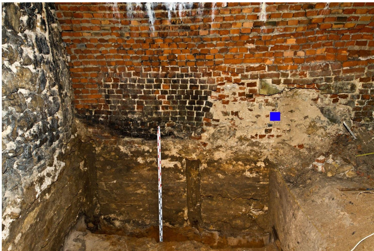
Ryc. 72 - Siewierz. Ściana wschodnia piwnicy wschodniego skrzydła. Na niebiesko miejsce pobrania próby do badań TL. Fot A. Ginter
