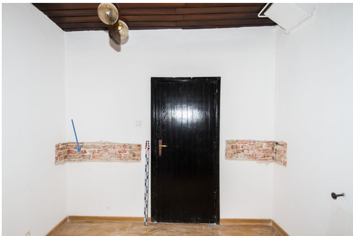
Ryc. 122 - Sulejów. Pomieszczenie 111 - ściana wschodnia. Strzałką zaznaczone miejsce pobrania próbki nr 5
