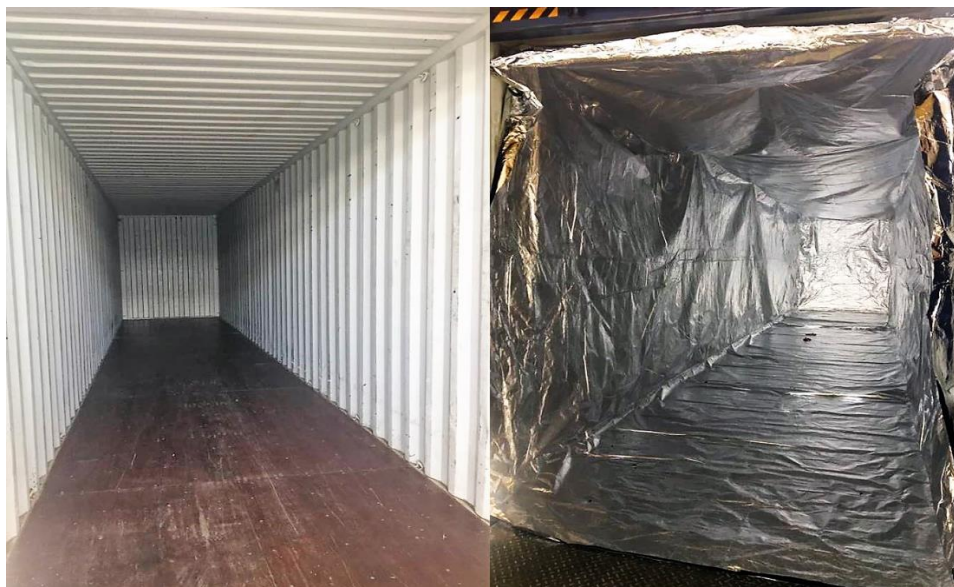
Rysunek 5.2. Kontener izolowany przed wypełnieniem i po wypełnieniu go izolacją PUR
