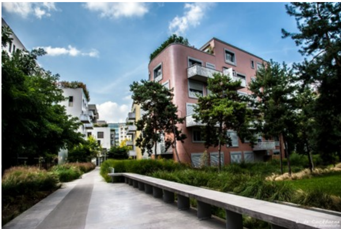
Ilustracja 3. Budynki mieszkaniowe w Boulogne-Billancourt, Francja.
