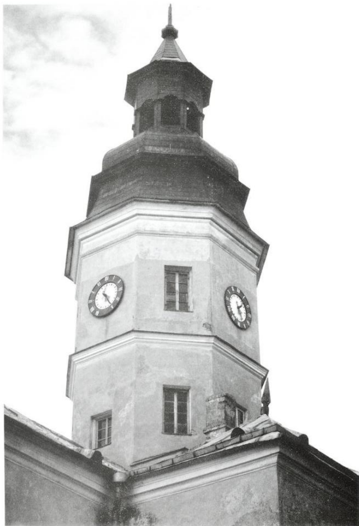
Ryc. 17. Zamek w Nieświeżu. Górne kondygnacje wieży przy skrzydle płd.-zach. Fot. T. Bernatowicz, 1995.
