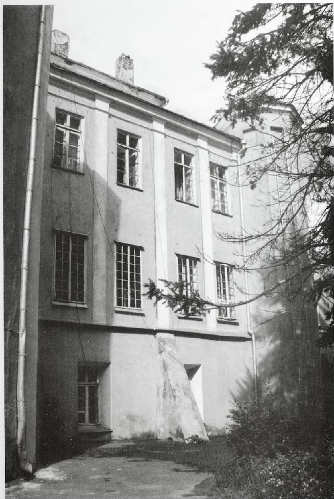
Ryc. 10. Zamek w Nieświeżu. Widok na fasadę boczną. Fot. T. Bernatowicz, 1995.
