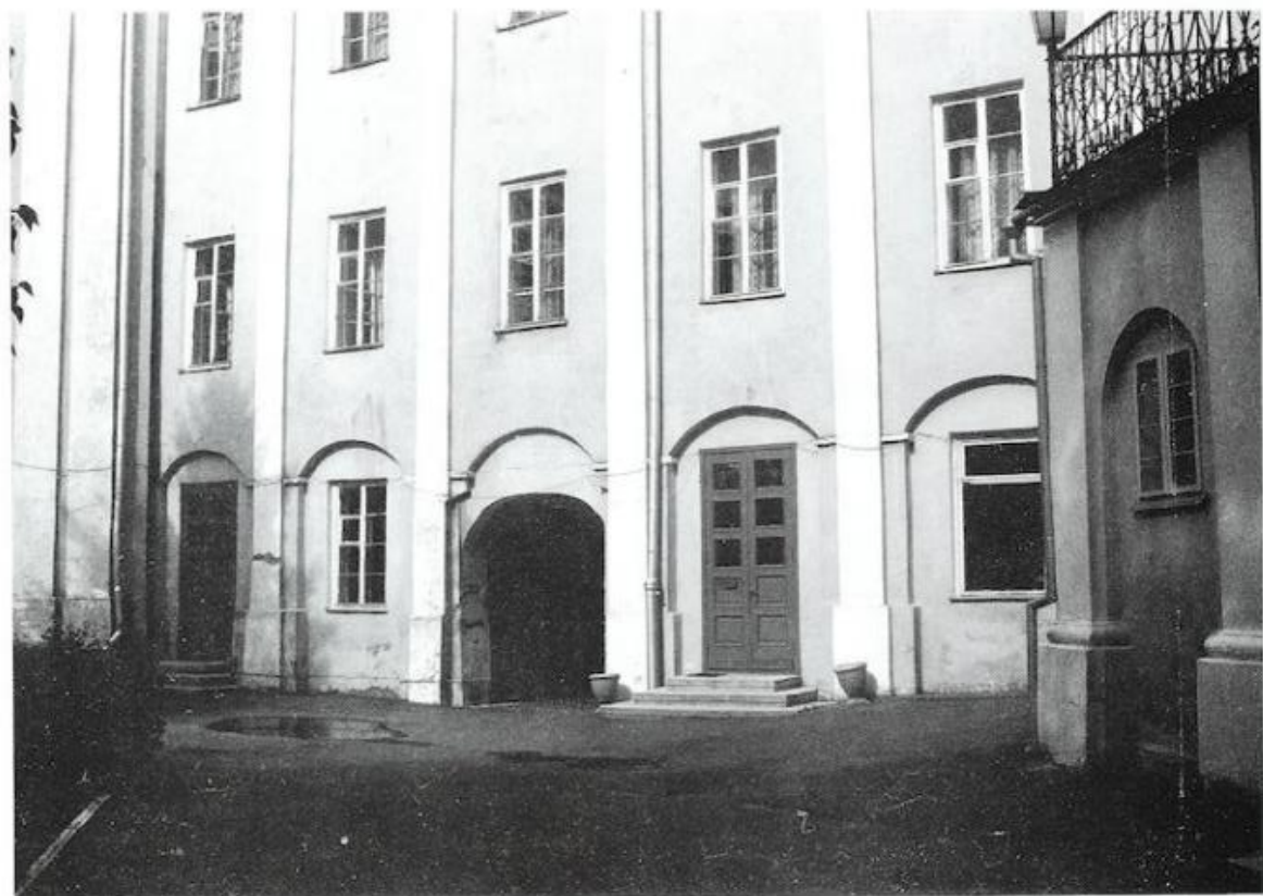
Ryc. 14. Zamek w Nieświeżu. Widok fasadę skrzydła północnego („galeria północna”). Fot. T. Bernatowicz, 1995.
