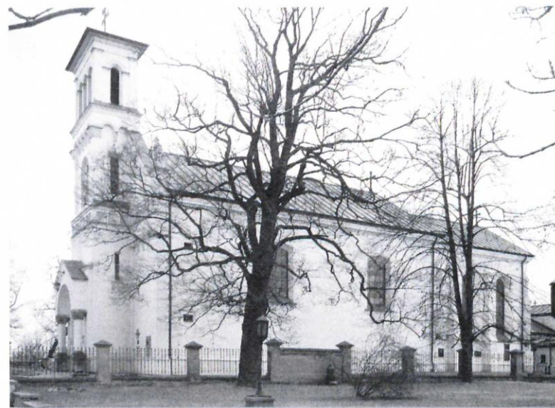
5. Kościół św. Katarzyny. Elewacja południowa, 2012 r.
