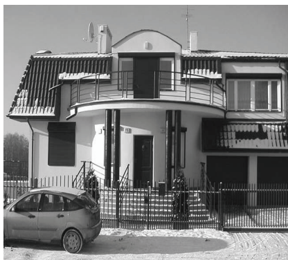
Fot. 12. Budynek zblźniaczony – Łódź Źródło: zdjęcie wykonane przez autora
