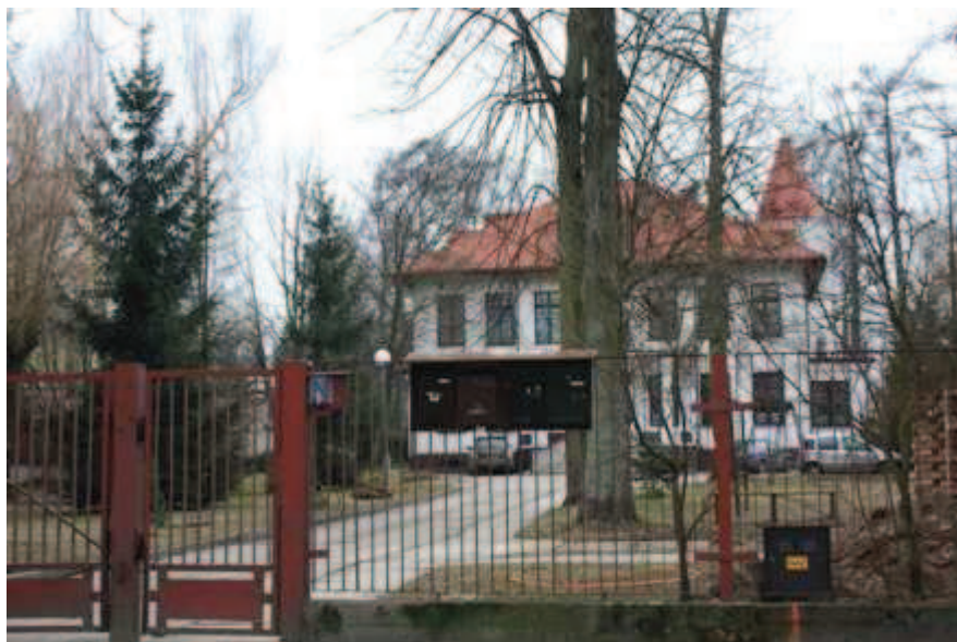
Fot. 7. Reprezentacyjny budynek wielorodzinny
