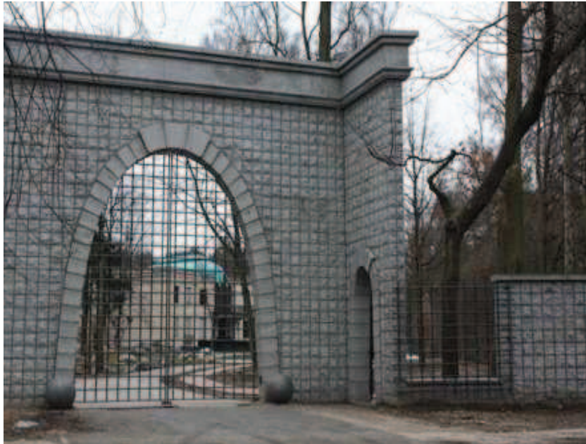
Fot. 2. Rezydencja w trakcie budowy Źródło: zdjęcie wykonane przez autora
