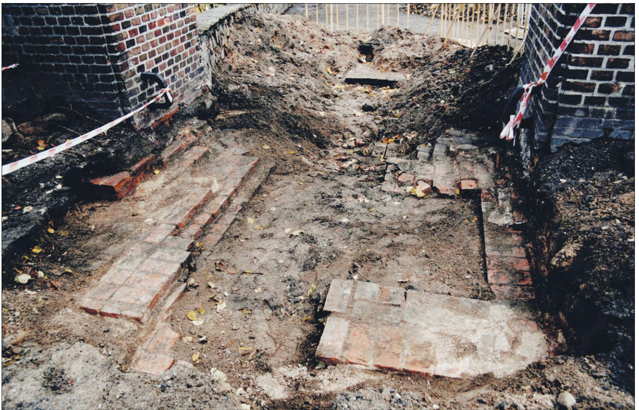
Ryc. 5.13 A – Lico muru przeciwskarpy fosi przy Bramie Północnej odkryte w 2008 r. (rysunek wykonany w Pracowni Informatyczno-pomiarowej Muzeum Archeologicznego w Gdańsku), B – Rzut komory mostu zwodzonego przy Bramie Północnej (fot. M. Kasprzak)
