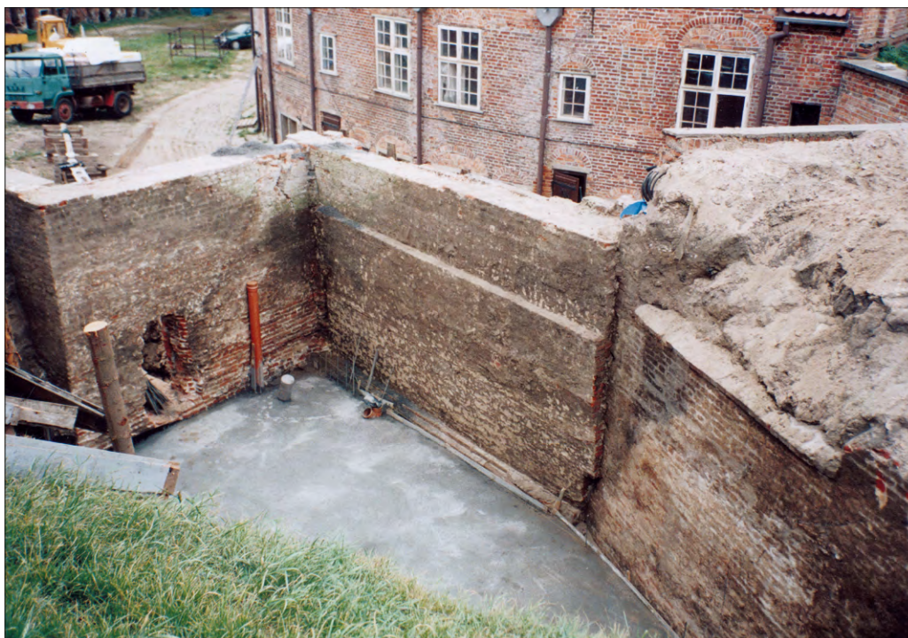
Ryc. 6.19 Widok ogólny na ścianę wschodnią potężny Bastionu Artyleryjskiego (prawa część zdjęcia), mur oporowy (część środkowa zdjęcia) i zachodni mur Domu Porucznika Piechoty po rozebraniu kanału burzowego i przebiciu nowego przejścia w murze (lewa część zdjęcia). Widok od NW (fot. M. Kasprzak)
