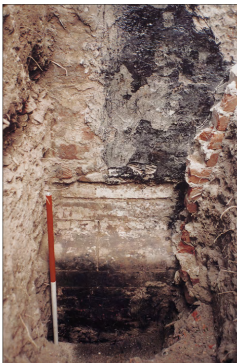
Ryc. 6.11 Zamurowane wejście do Wieńca od strony kurtyny zachodniej powstałe po usypaniu wału w tej części Fortu Carre. Zamurowane po podniesieniu poziomu nasypów w końcu XVIII bądź na początku XIX w. Zbliżenie na fragment progu. Widok od W (fot. M. Kasprzak)
