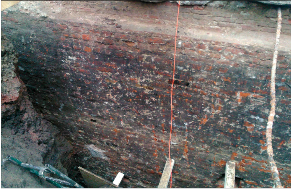
Ryc. 3.38 Fragment ściany gotyckiej kamienicy, na której posadowiono ścianę wschodnią Wielkiej Zbrojowni. Odcinek pomiędzy basztami. Widok od NE (fot. P. Muntowski)
