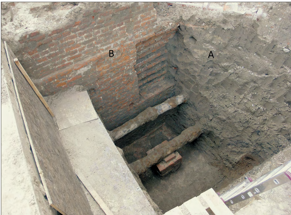
Ryc. 4.16 Widok ogólny na południowo-zachodni odcinek muru zamykającego od południa dziedziniec Bramy Wyzynnej (rys. D. Dyduch). W dole ołowiana i żeliwna rura wodociągowa. Widok od NE. A – Zasyw z XIX w., B – Ściana zamykająca od południa dziedziniec (fot. i oprac. M. Kasprzak)
