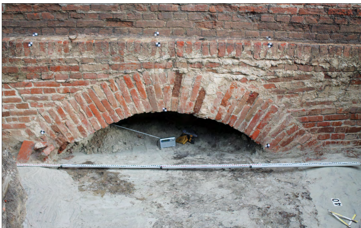
Ryc. 5.8 Fundament przeciwskarpy fosy – wykopu 9 (fot. M. Szyszka)
