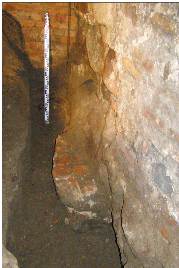
Ryc. 4.4 Fundament muru łączącego ścianę wschodnią i środkową piwnicy w pomieszczeniu P1 (patrz ryc. 4.10). Widok od W (fot. i oprac. M. Kasprzak)
