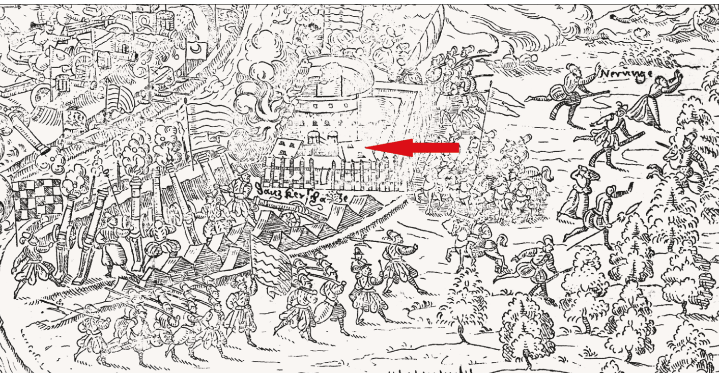
Ryc. 6.4 Fragment reprodukcji sztychu przedstawiającego oblężenie Wisłoujścia z 1577 r. (Stankiewicz 1956, s. 129, ryc. 11). Strzałką oznaczono poziom dolny Wieńca obecnie znajdujący się pod ziemią
