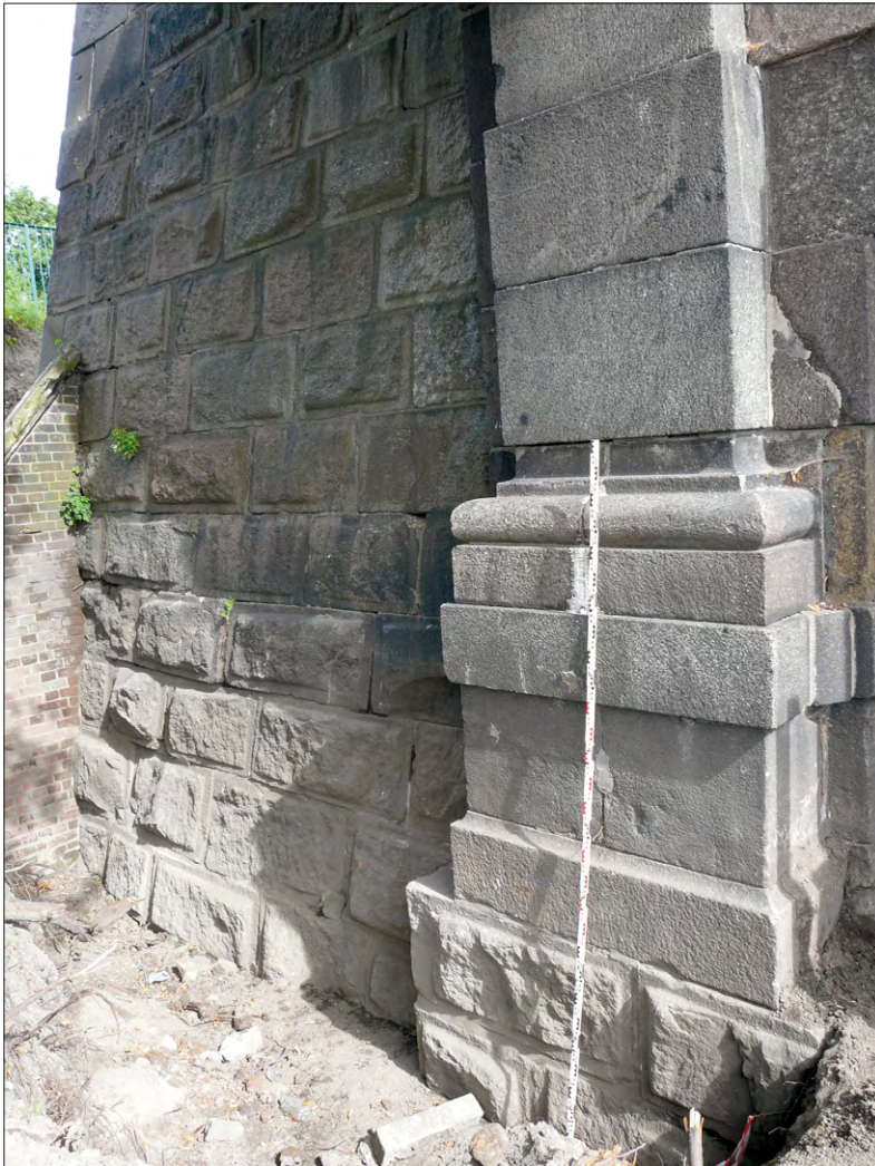
Ryc. 3.30 A – Przejazd bramny, widoczny pacholek wyznaczający pierwotny poziom użytkowy przejazdu oraz nawarstwienia podnoszące teren w XX w., widok od NE, B – Odsłonięte fragmenty okładziny poniżej współczesnego poziomu użytkowego – strona zachodnia, widok od S (fot. M. Kasprzak)
