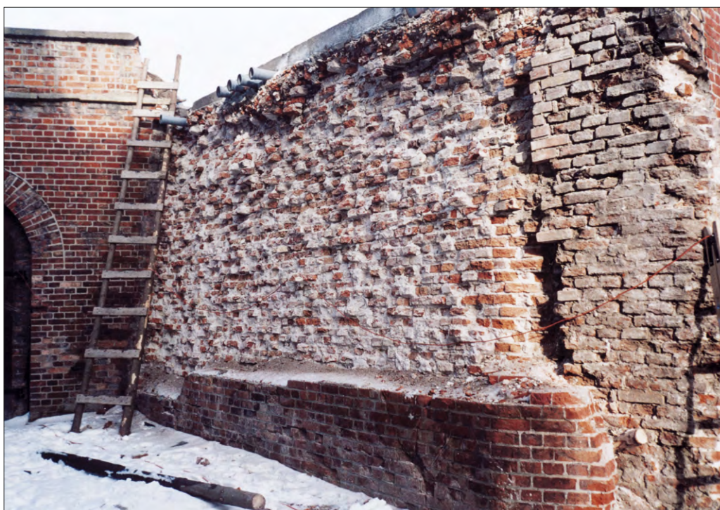
Ryc. 6.20 Mur oporowy przy poternie do Bastionu Artyleryjskiego po zdjęciu lica z cegły maszynowej z lat 70-tych XIX w. Widok od SE (fot. M. Kasprzak)
