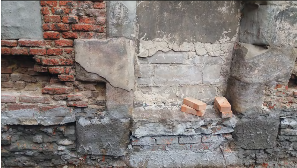
Ryc. 3.28 Fragment ściany wschodniej wartowni zachodniej podczas prac konserwatorskich. Zbliżenie na dolną część zamurowanego otworu przejścia, widok od E (fot. M. Kasprzak)
