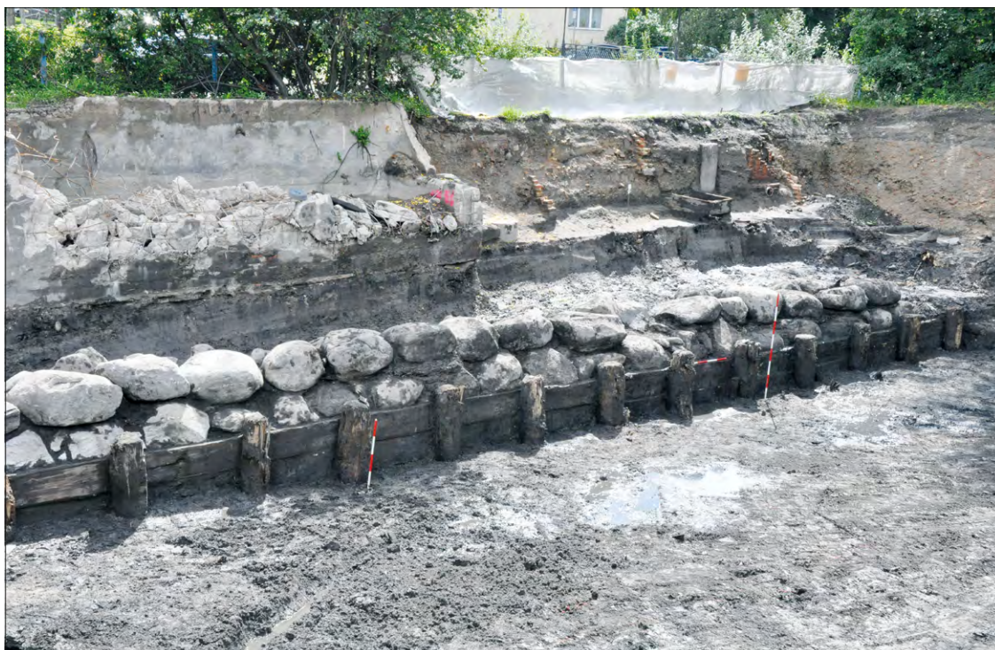
Ryc. 2.11 Kamiennie i drewniane umocnienia grobli na Starym Mieście odkryte przy ulicy Wałowej 40. Widok od N (fot. i oprac. A. Longa)
