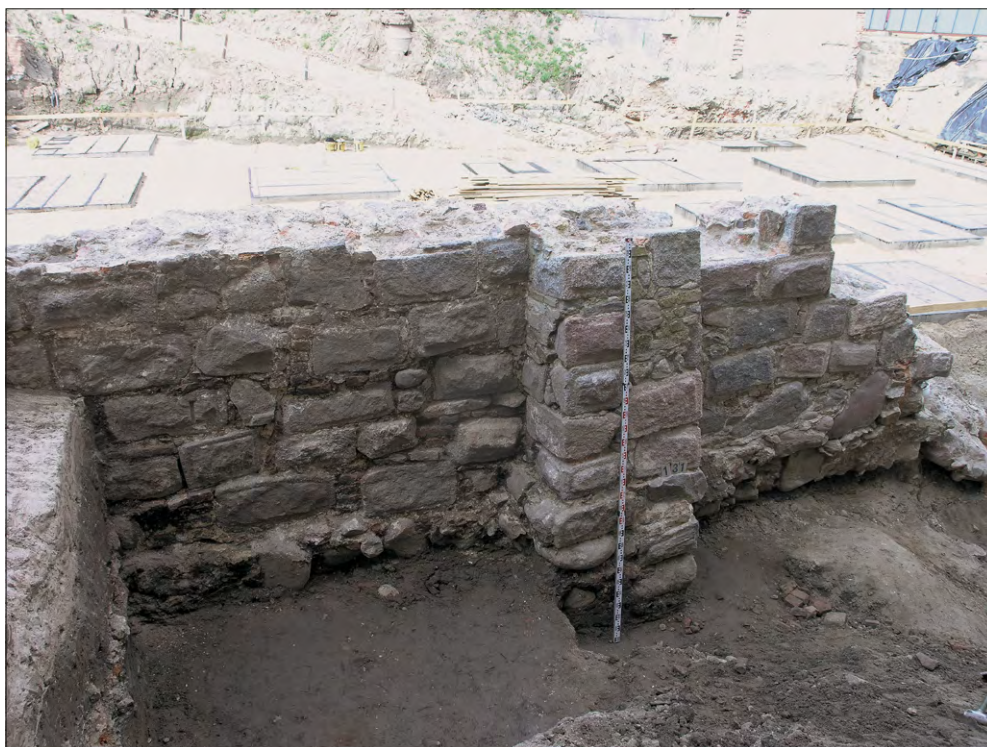
Ryc. 5.4 A – widok na wały i bramę Nowych Ogrodów z bastionu Piaskowego, 1919 r. (Tusk, Duda, Fortuna, Był sobie Gdańsk 2006, s. 224–225). Literą A oznaczono miejsce lokalizacji muru, B – pozostałości dolnej części muru skarpowego (M23) od strony wewnętrznej wału (fot. J. Prager)
