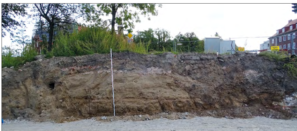
Ryc. 3.7 A – Lico zachodnie czoła Bastionu Kot, prawe ramię. Widok od SW (fot. M. Kulesz-Hodysz), B – Lico wschodnie muru wewnętrznego barku Bastionu Kot z widoczną koroną muru barku z kaza- matami dolnymi. Widok od E (fot. M. Kulesz-Hodysz), C – Fragment zachowanego nasypu Bastionu Kot. Widok od S (fot. M. Kulesz-Hodysz)
