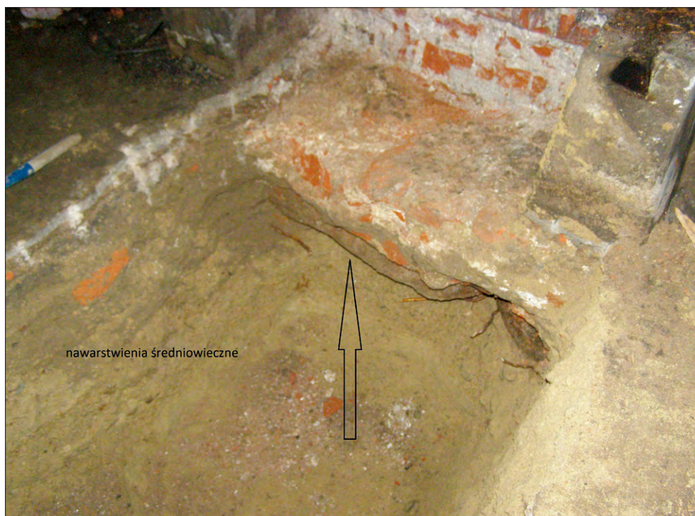
Ryc. 2.7 Mur 1 w sondażu 2. Strzałką oznaczono spąg fundamentu. Powyżej nieskuta część muru z oryginalnym licem. Widok od SW (fot. i oprac. M. Kasprzak)
