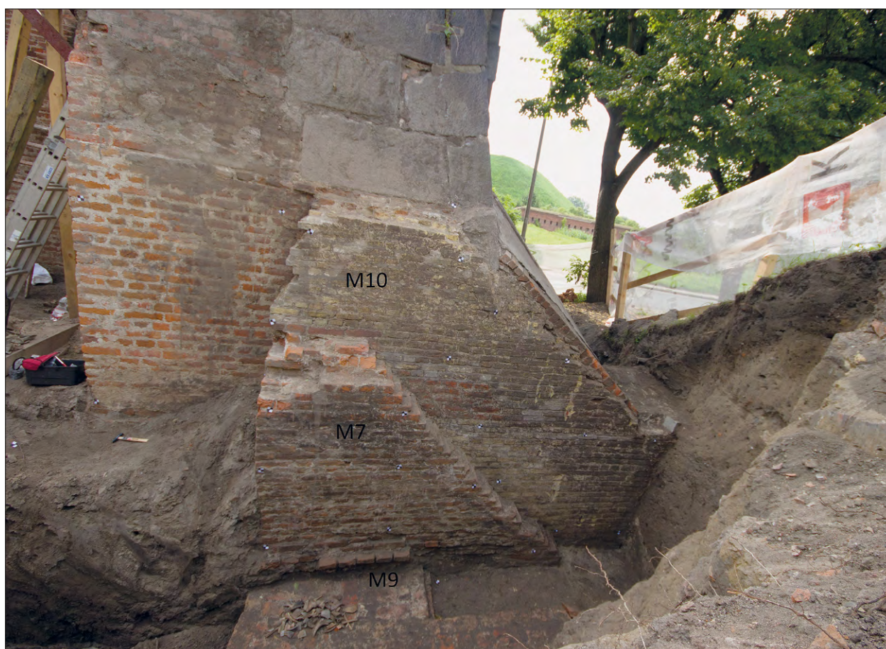
Ryc. 3.32 Zachodnia przypora zewnętrzna z murem oporowym z nadbudową (mur 7, 9, 10). Widok od W (fot. P. Muntowski)
