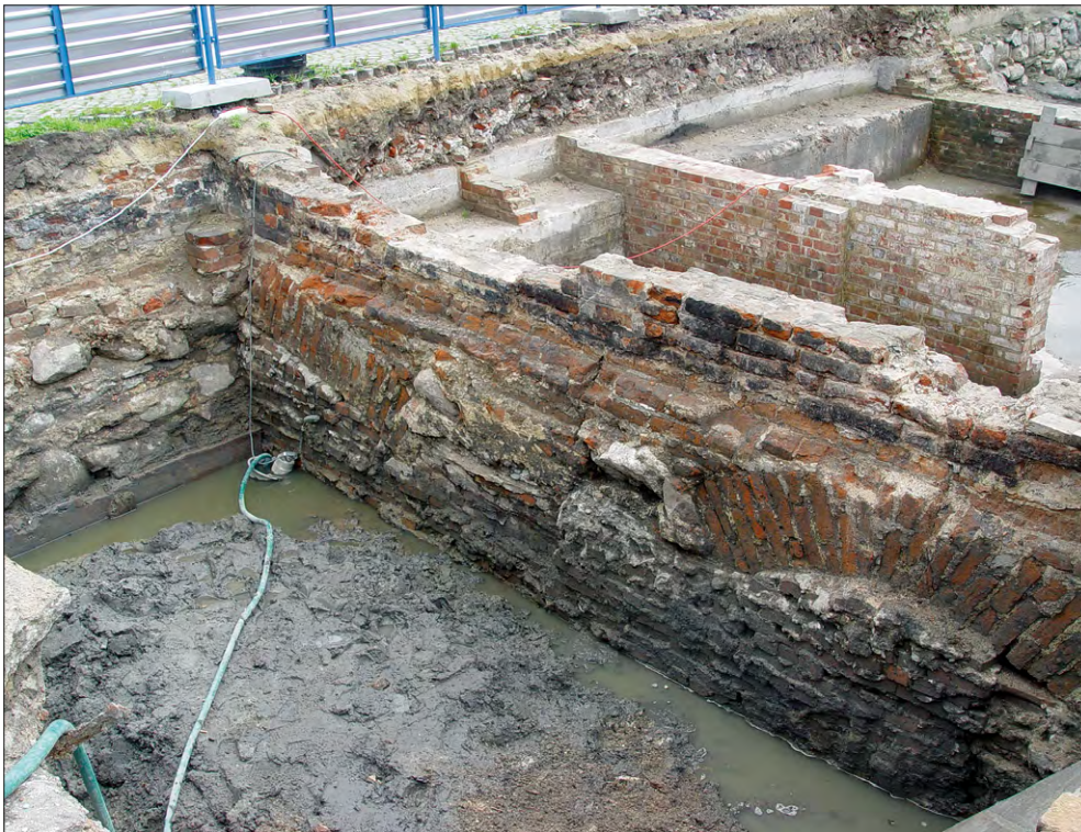
Ryc. 2.4 Fragment fundamentu łukowego południowej ściany budynku bramnego – nieistniejącej Bramy św. Tobiasza. Widok od NE (fot. P. Matuszewski)
