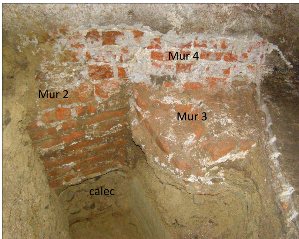
Ryc. 2.8 Mur 2-4 w sondażu 2. Widok od NE (fot. i oprac. M. Kasprzak)
