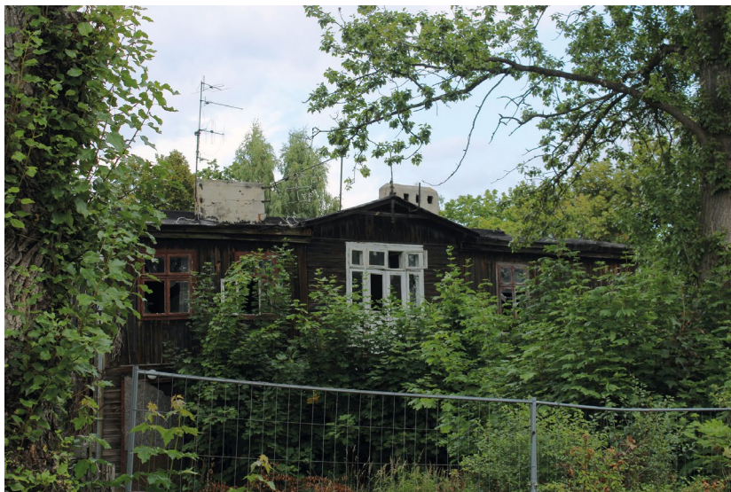
Fotografia 6. Drewniak przy ulicy Wiośnianej 4
