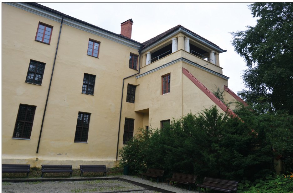
2. Gmach dawnego Wydziału Sztuk Pięknych USB – widok od strony ogrodu bernardyńskiego; fot. autor, 2025
