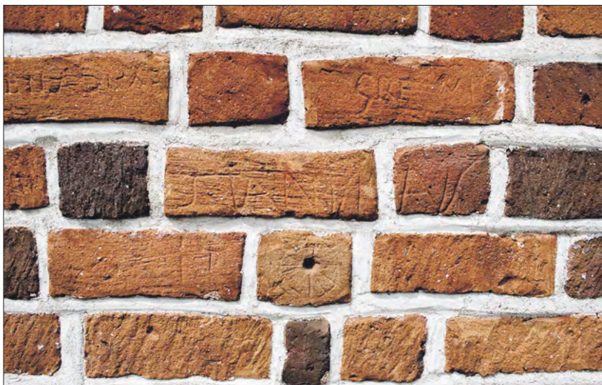
Ryc. 3. Zróżnicowanie ingerencji w elewację kościoła pw. św. Mikołaja BW w Mierzynie. Fot. A. Piotrowska.
