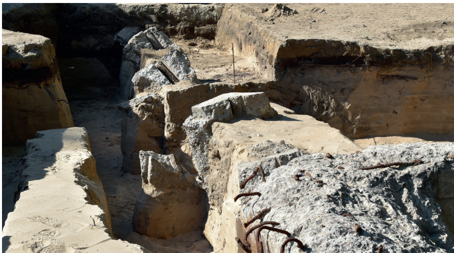
Ryc. 8. Relikty betonowych fundamentów zapory/ogrodzenia z siatki Ledóchowskiego, biegnącej od południowo-wschodniego narożnika wartowni nr 5 na południe. Widok od północy. Po prawej na dole widoczny fragment południowo-wschodniego narożnika wartowni (źródło: MIIWŚ)
