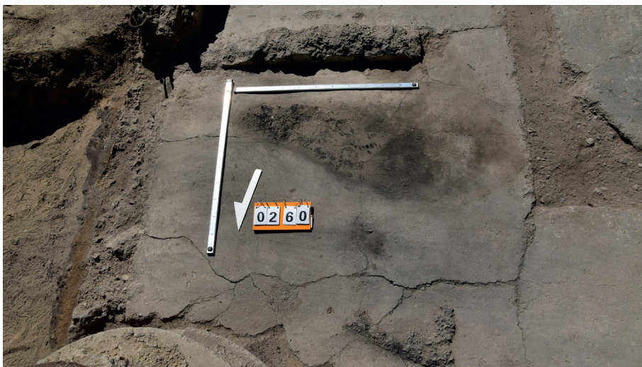
Ryc. 13. Warstwa spalenizny na posadzce północno-wschodniego pomieszczenia na rkm w wartowni nr 5. Świadekstwo pożaru, do którego doszło w dolnej kondygnacji budynku po bombardowaniu Luftwaffe 2 września 1939 r. Widok od północy (źródło: MIIWŚ)
