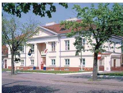
Fot. 7. Budynek zajazdu pocztowego w Łowiczu – obecna siedziba Urzędu Poczty i Telekomunikacji (Miejski Informator Aktualności Łowicz)
