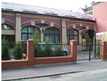
Fot. 37. Rezydencja Spalska w Spale (materiały promocyjne obiektu)
