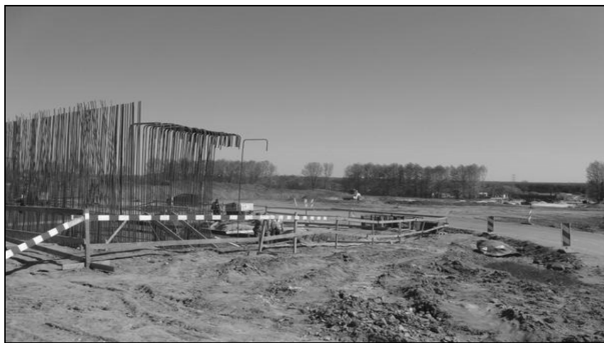
Fot. 5.3. Budowa obwodnicy: montaż zbrojenia pod wiadukt (zdjęcie: J. Malikowski)
