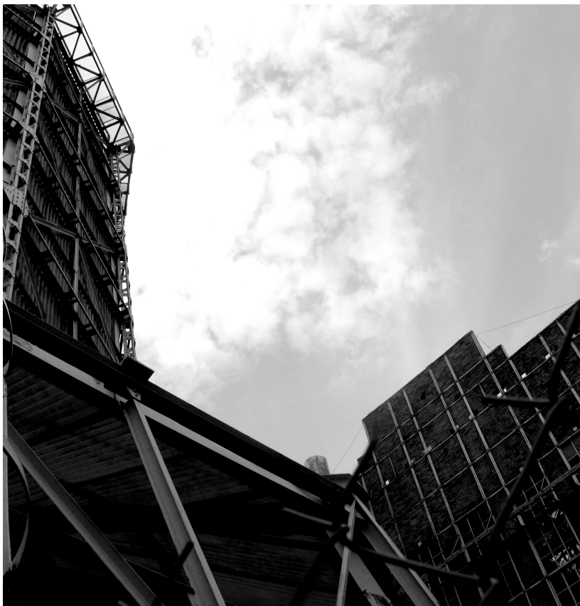
Elektrociepłownia EC1 w Łodzi fot. Jakub Zasina
