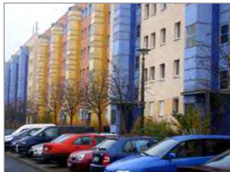
Fot. 2. Przykład modernizacji budynku w osiedlu Hellersdorf w Berlinie z odnowioną elewacją i wejściami do klatek schodowych oraz dobudowanymi przy każdym wejściu, zewnętrznymi szybami windowymi (źródło: Łodziński 2009)
