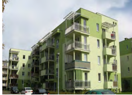
Fot. 13. Nowa zabudowa mieszkaniowa powstała po 2000 r. w osiedlu Olechów
