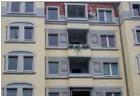
Fot. 1. Przykład zastosowania tzw. malarstwa iluzorycznego imitującego detal architektoniczny, zieleni, ptaki, dachówki itp. w celu wizualnego uatrakcyjnienia płaskiej elewacji budynku z wielkiej płyty w osiedlu Hellersdorf w Berlinie (źródło: Łodziński 2009)
