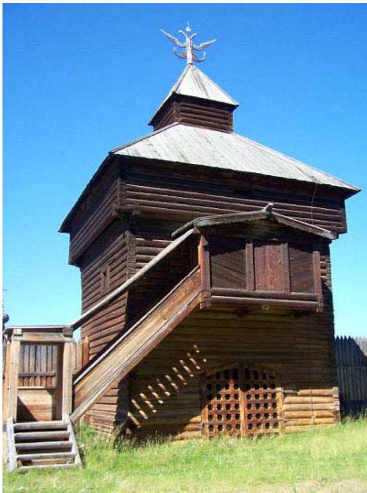
Fot. 9. Baszta obronnego miasta Ilimsk na Syberii zrekonstruowana w skansenie.
