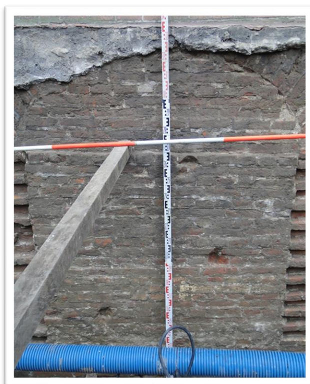
Ryc.3.51 A Fragment lica zachodniego muru niskiego gotyckich umocnień Głównego Miasta na, którym posadowiono zachodnią ścianę Wielkiej Zbrojowni (zbliżenie). Widok od W B Fragment lica zachodniego muru niskiego gotyckich umocnień Głównego Miasta na, którym posadowiono zachodnią ścianę Wielkiej Zbrojowni. Widoczne zamurowany otwór przepustu dla rur wodociągowych. Strzępia wokół niego prawdopodobnie miały służyć przewiązaniu ze ścianą Wielkiej Zbrojowni ceglanego sklepionego od góry kanału. Widok od SW
