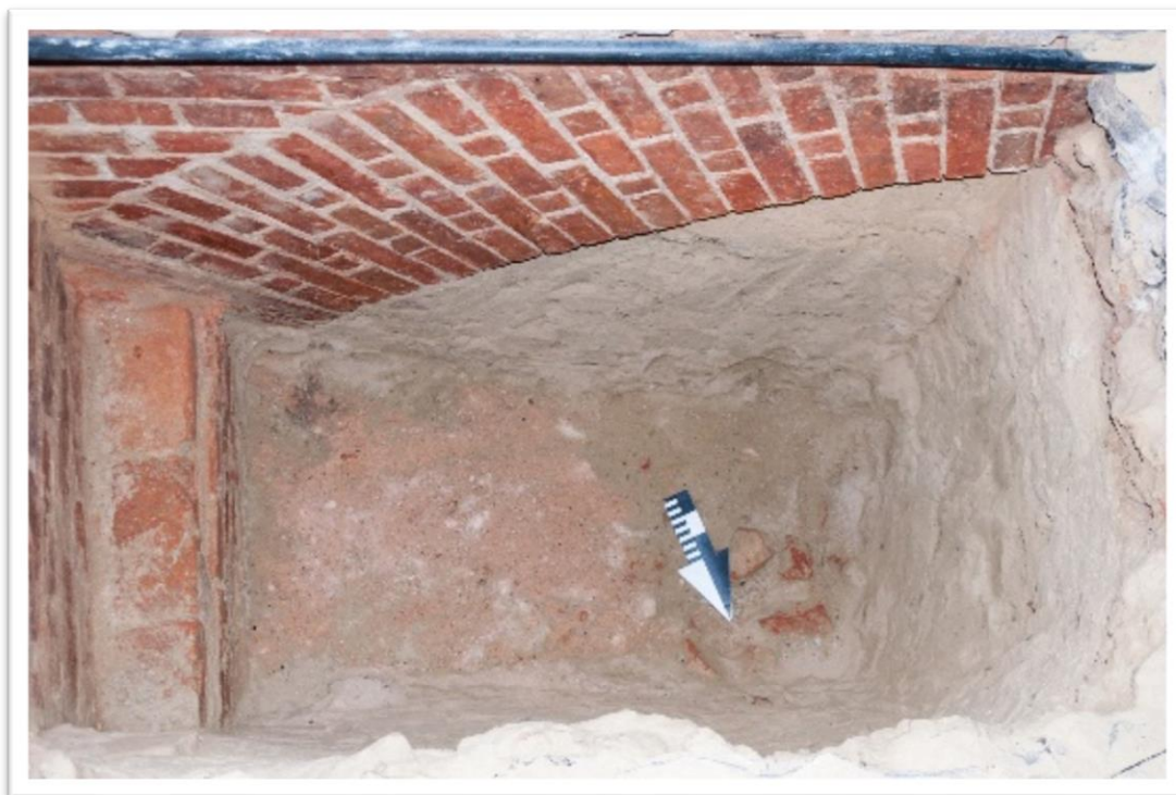
Ryc.5.28 Badania archeologiczne z 2016 roku. Odkrywka III mur nr 5, fundament łękowy i warstwa nr 25 (fot. P. Muntowski)
