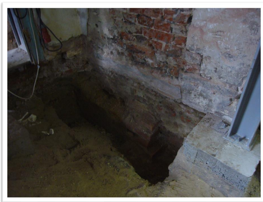
Ryc.4.53 Mur dostawiony do ściany zachodniej najprawdopodobniej podczas remontu elewacji zachodniej w latach 60 – tych XIX wieku. Widok od NE (fot. M. Kasprzak)
