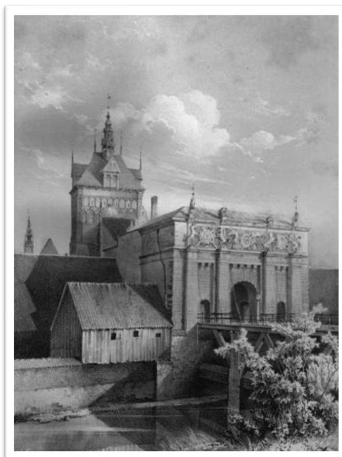
Ryc.4.6 Litografia przedstawiająca Bramę Wyżynną wykonana przez K. Beyera w 1855 r. Na rysunku widoczne ubytki na dolnej ceglanej części elewacji zachodniej (Tusk, Duda, Fortuna, Nawrocki, 1996, s.53)
