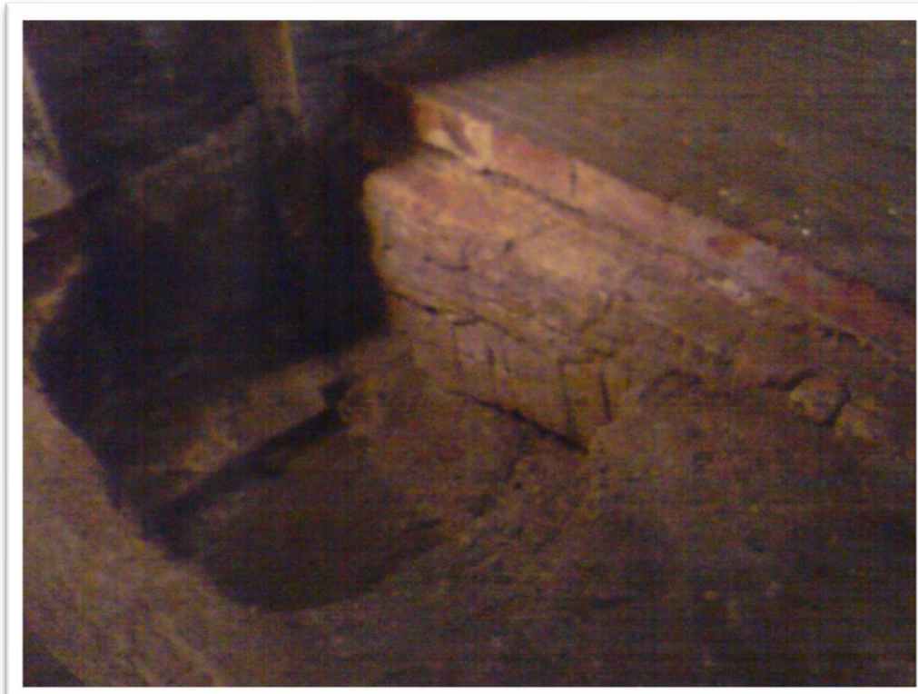
Ryc.6.44 Fundament łukowy umieszczony pomiędzy filarami odsłonięty po zapadnięciu się fragmentu posadzki w Bastionie Furta Wodna. Po lewej stronie zdjęcia podstawa filara. Widok od NW. (fot. Monika Kasprzak)
