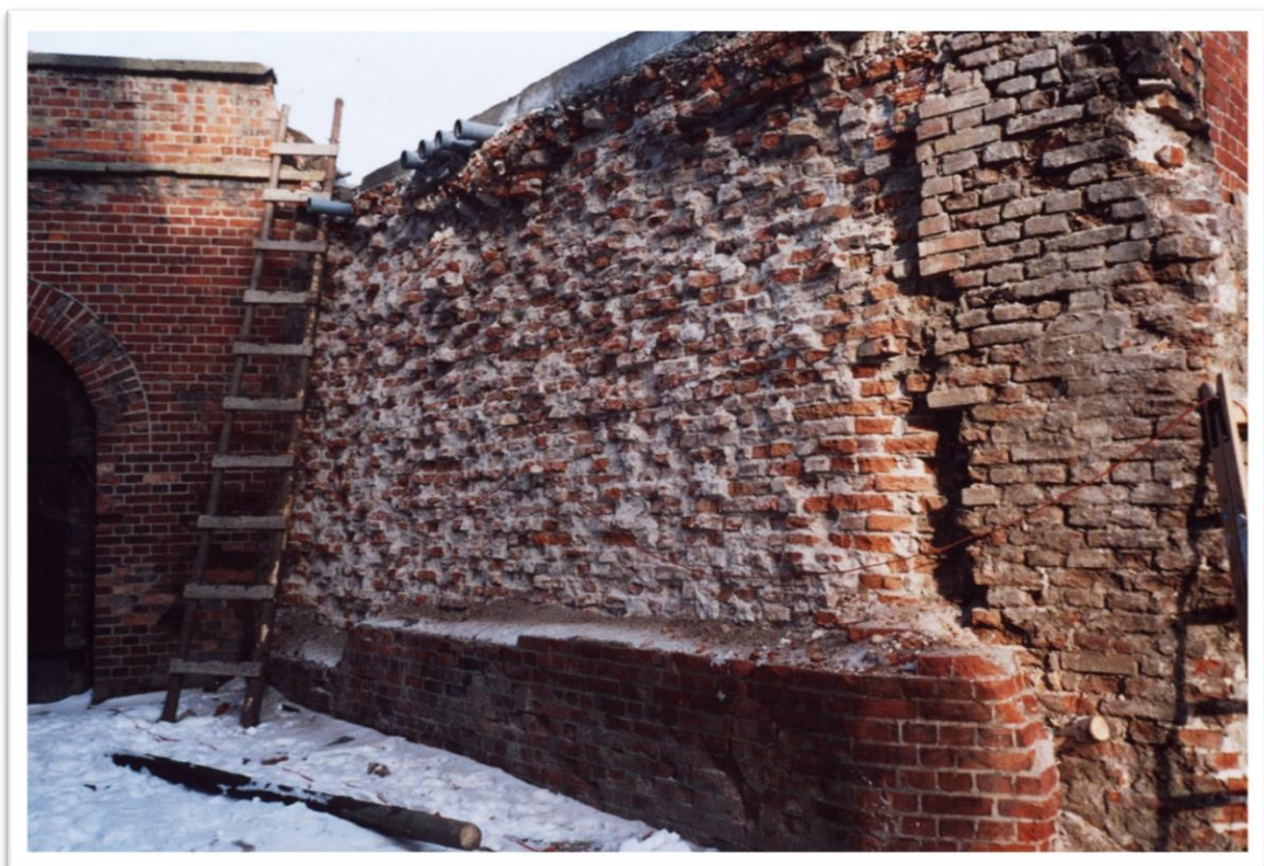
Ryc.6.29 Mur oporowy przy poternie do Bastionu Artyleryjskiego po zdjęciu lica z cegły maszynowej z lat 70 tych XIX wieku. Widok od SE (fot. M. Kasprzak)
