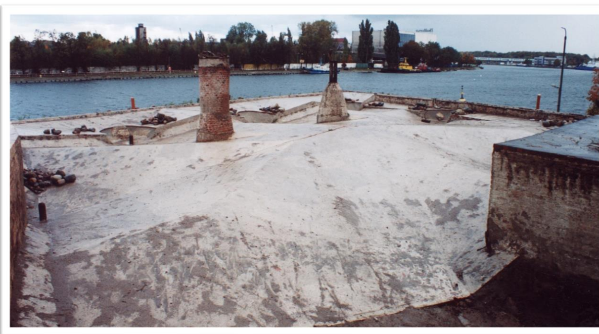
Ryc.6.55 Bastion Artyleryjski B. Fragment podstawy działa. W prawnej części zdjęcia widoczne pozostałości pierwotnej ściany wewnętrznej lewego barku bastionu . Widok od N., C stropy sklepień po zdjęciu nasypu. Widoczne górne części syfonów. Widok od SE (fot. M. Kasprzak)
