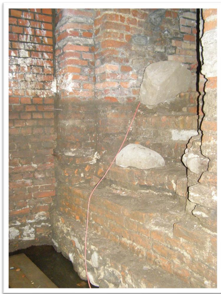
Ryc.4.19 Widok na północno – wschodni narożnik piwnicy. Po prawej widoczny najstarszy poziom schodów wykonanych w grubości ściany północnej (fot. M. Kasprzak)
