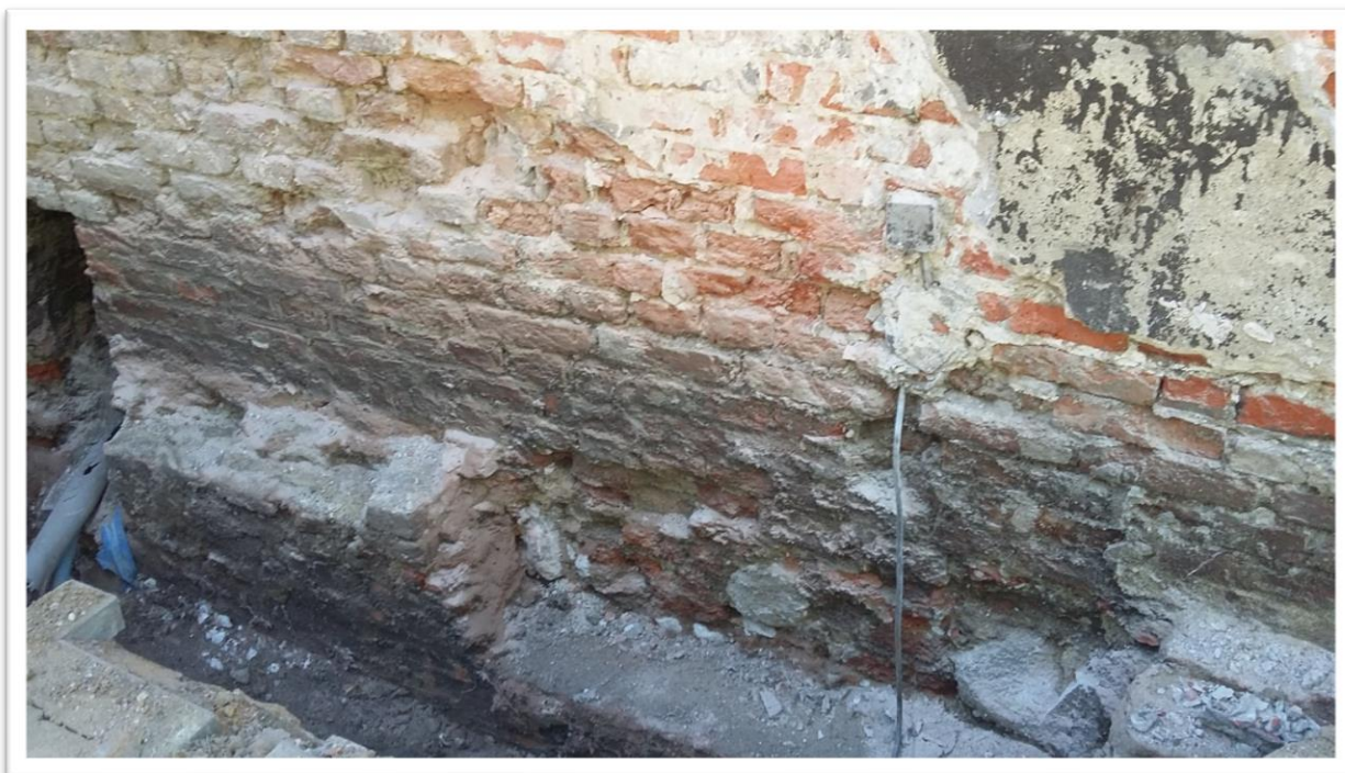
Ryc.3.41 A Fragment ściany wschodniej wartowni zachodniej podczas prac konserwatorskich. Zbliżenie na dolną część zamurowanego otworu przejścia, widok od E B Fragment ściany wschodniej wartowni wschodniej podczas prac konserwatorskich, widok od E (fot. M. Kasprzak)
