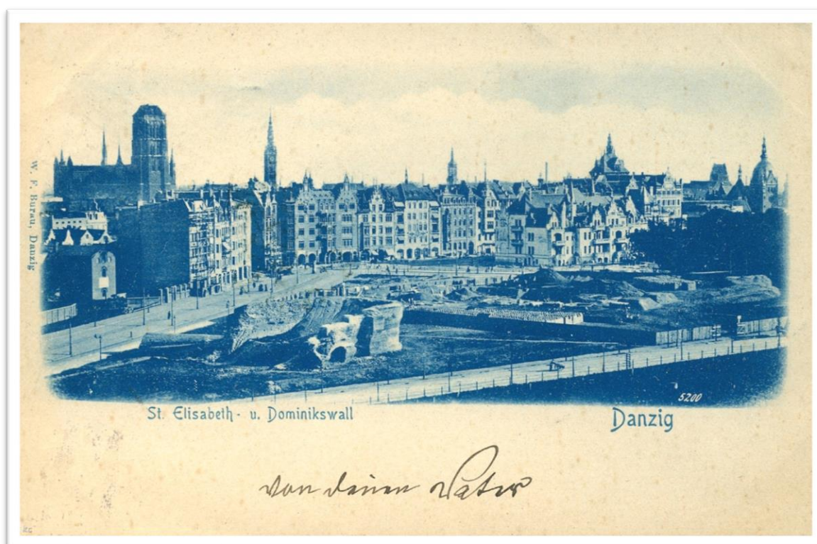
Ryc.3.6 Bastion św. Elżbiety w trakcie rozbiórki na początku XX wieku. W głębi fotografii XVI wieczna podkowiasta konstrukcja użytkowana jako magazyn prochowy (Tusk, Duda, Fortuna, Nawrocki 1996, s.14)
