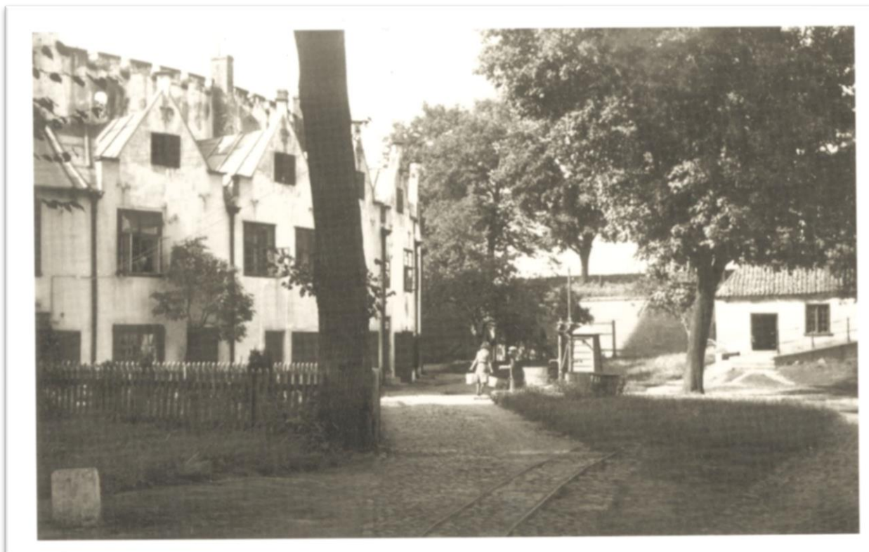
Ryc.6.41 Fotografia z okresu międzywojennego pokazująca północną część dziedzińca Fortu Carre. Po prawej stronie widoczny budynek kuźni przebudowany na dom mieszkalny (Tusk,Duda, Fortuna, Nawrocki 1997, s.79)
