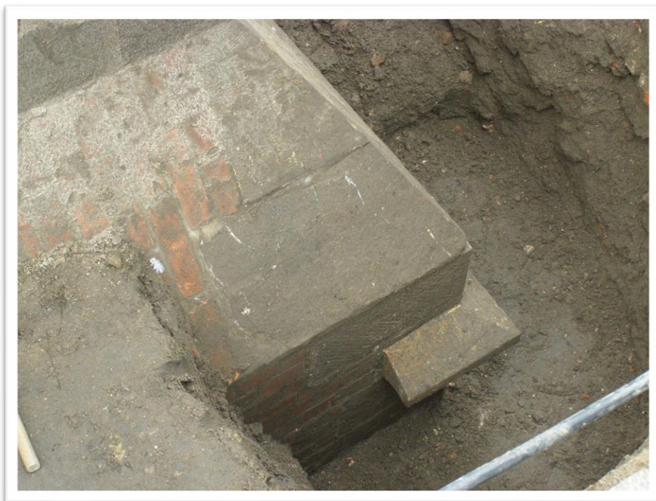
Ryc.4.36 Sondaż 1 z 2010 roku. Zbliżenie na północno – zachodni narożnik ściany północnej z XIX wiecznym okapem. Widok od NE (fot. M. Kasprzak)
