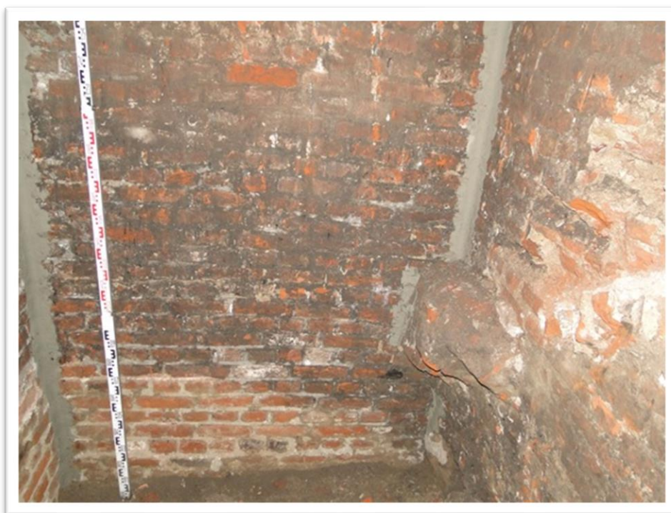
Ryc.3.55 B Fragment ściany gotyckiej kamienicy na, której posadowiono ścianę wschodnią Wielkiej Zbrojowni. W prawym rogu widoczne skute schody. Odcinek południowy, część dolna. Widok od E (fot. P. Muntowski)
