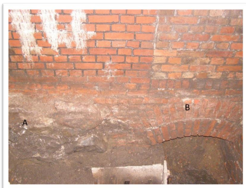
Ryc.4.16 A. Fundament zamurowanego przejścia do fosbrei w południowej części piwnicy, B. Odsadzki fundamentowe ściany zachodniej piwnicy. Widok od N (fot. i oprac. M. Kasprzak)
