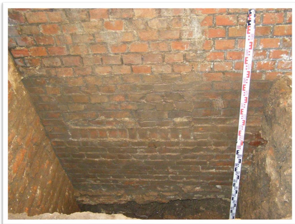
Ryc.4.17 Fundament zamurowanego przejścia do fosbrei w północnej części piwnicy. Widok od S (fot. M. Kasprzak)
