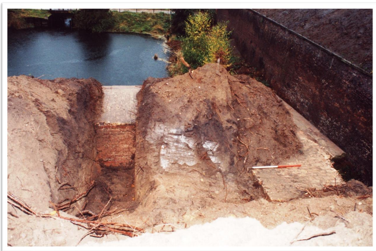
Ryc.6.46 Prawy bark Bastionu Ostroróg - wnętrze wypełnione ziemią. Widok od N (fot. M. Kasprzak)
