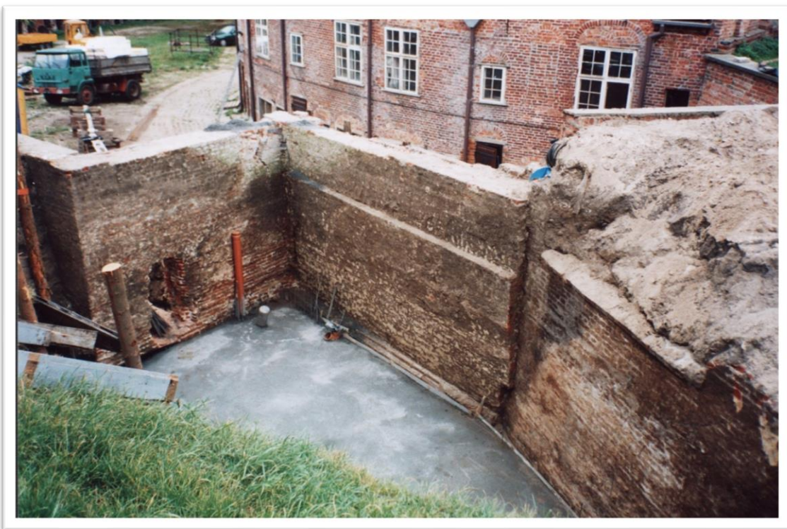
Ryc.6.28 Widok ogólny na ścianę wschodnią poterny Bastionu Artyleryjskiego (prawa część zdjęcia), mur oporowy (część środkowa zdjęcia) i zachodni mur Domu Porucznika Piechoty po rozebraniu kanału burzowego i przebiciu nowego przejścia w murze (lewa część zdjęcia) . Widok od NW (fot. M. Kasprzak)
