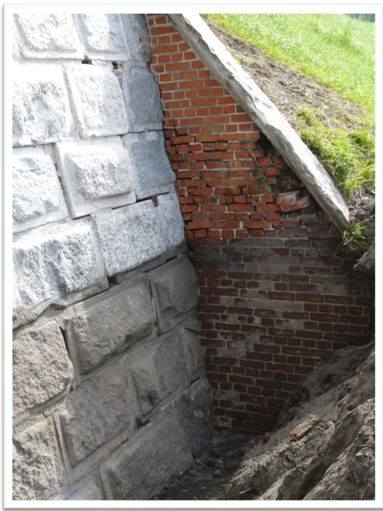
Ryc.3.44 Widok ogólny na zachodnią część ściany południowej. A przypora zewnętrzna B przypora wewnętrzna
