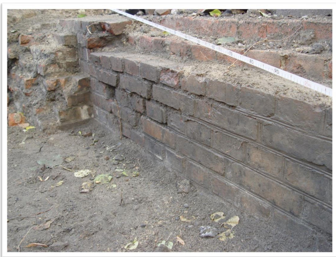
Ryc.5.42 Zbliżenie na jedną ze ścian komory mostu zwodzonego. Widok od NW (fot. M. Kasprzak)
