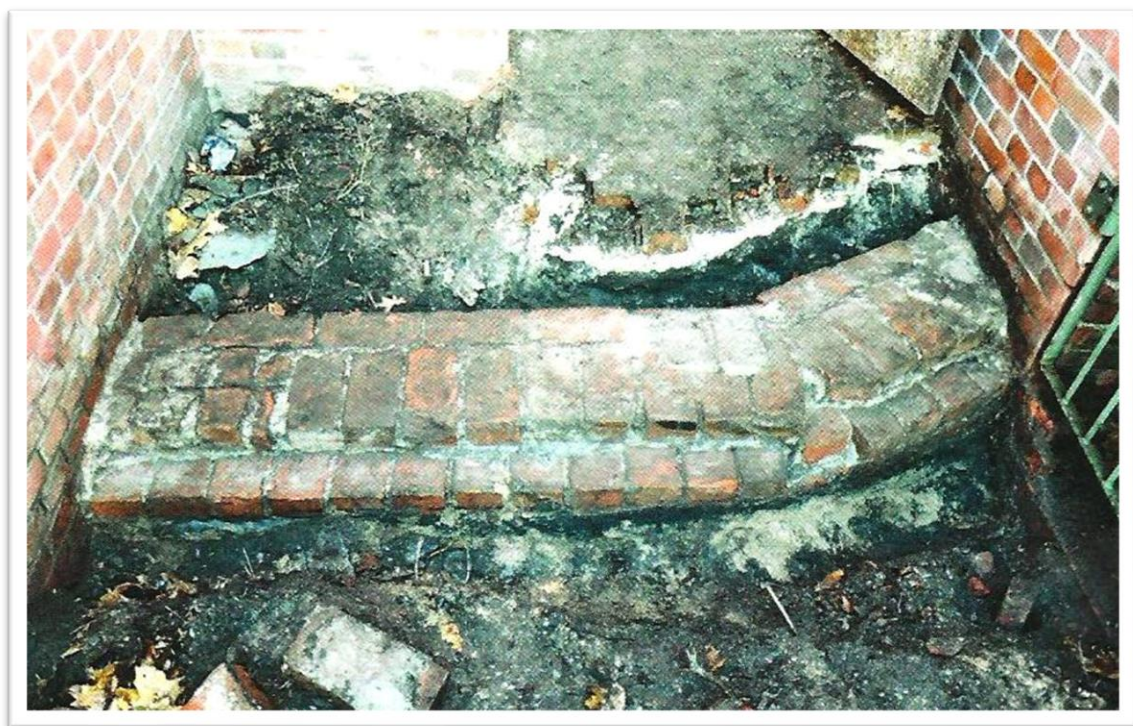
Ryc.5.52 A fundamentowa część muru wykonana z łamanych kamieni, przewiązana z fundamentem Galerii odsłonięta w wykopie I z 2010 roku B Fragment muru wzmacniającego dostawionego do muru Galerii Strzeleckiej wykop VI z 2010 roku,
