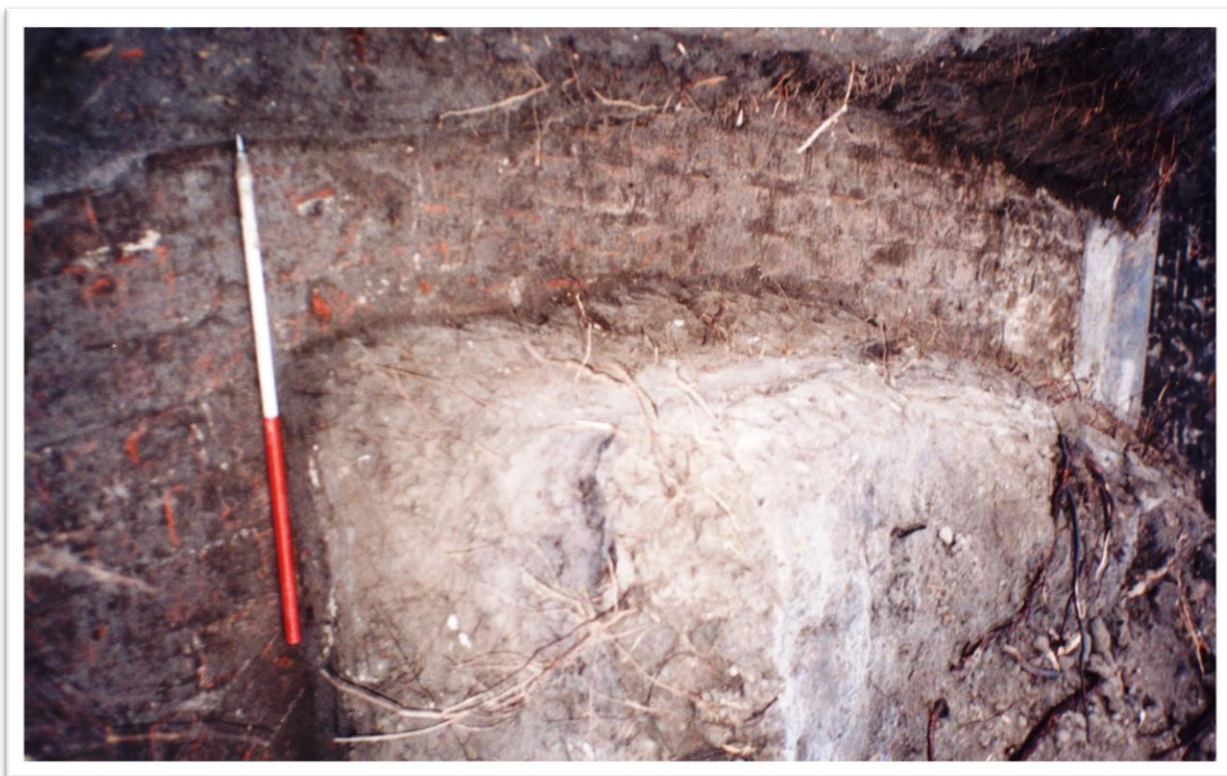
Ryc.6.45 Fragment ceglanego stropu odsłoniętego po częściowym zdjęciu nasypu z prawego barku Bastionu Południowo- wschodniego. Widok od W (fot. M. Kasprzak)
