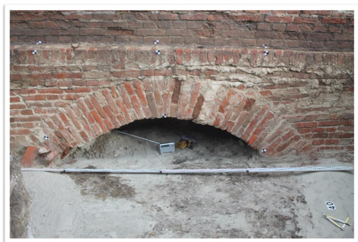
Ryc.5.20 A otwór wentylacyjny -wykop 7 B -fundament przeciwskarpy fosi - wykopu 9 (fot. M. Szyszka)
