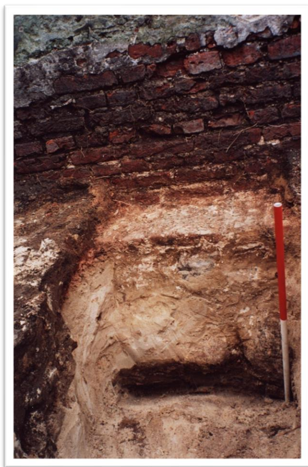
Ryc.6.20 Fragment fundamentu muru południowej fosbrei od strony nasypu. Widoczna ceglana odsadzka i kamienny fundament połączony zaprawą wapienną. Widok od N (fot. M. Kasprzak)
