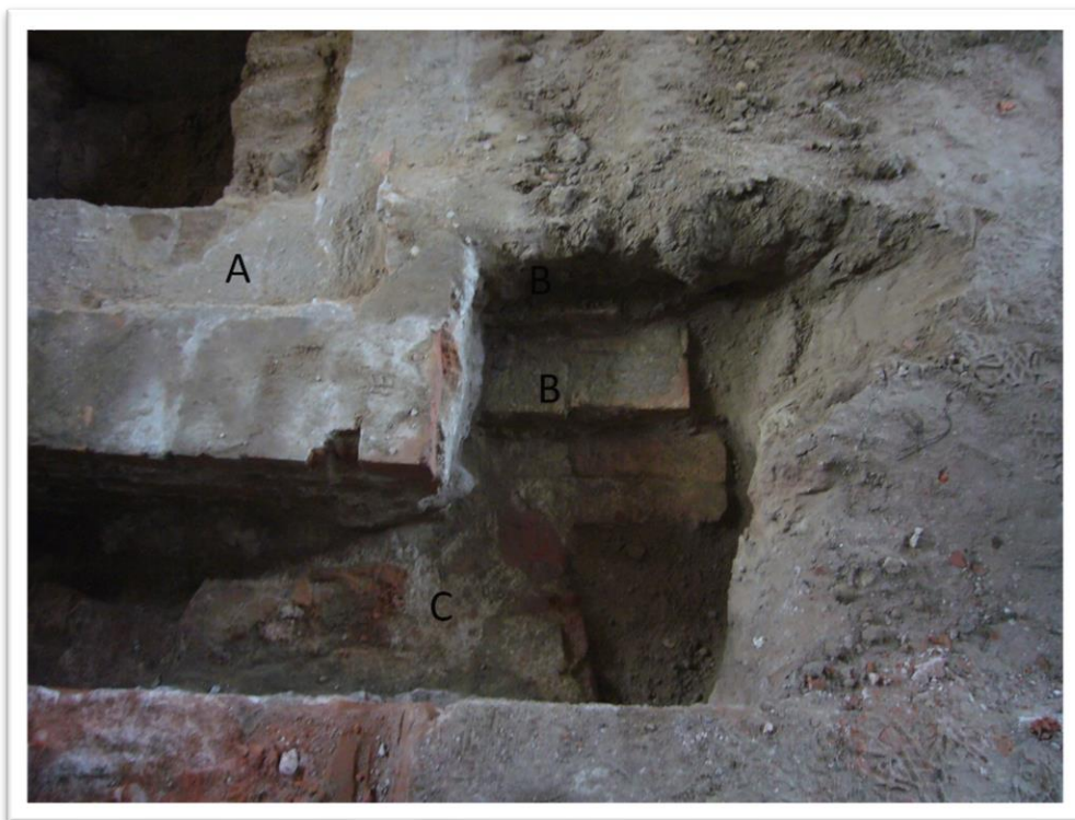
Ryc.4.55 A Zbliżenie na S – E narożnik wschodniej ściany ostatniego mostu. B fragment ściany starszej konstrukcji mostu. C fragment najstarszego muru zanotowanego podczas nadzorów z zalegającym na nim murze z cegły dziurawki. Widok od S (fot. i oprac. M. Kasprzak)
