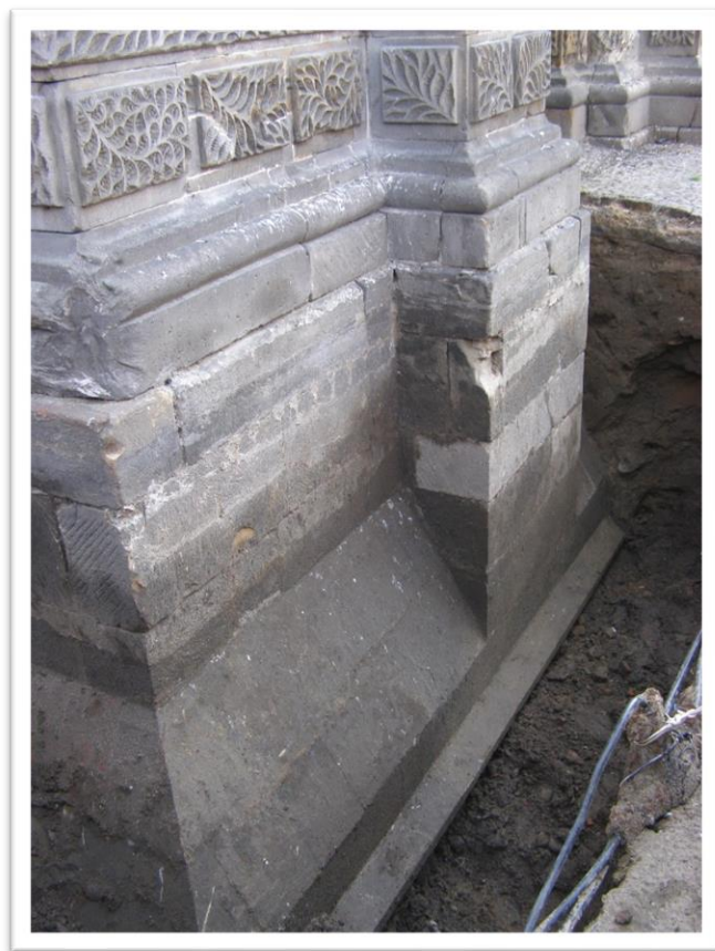
Ryc.4.34 Sondaż 1 z 2010 roku. Widok na północnowschodni narożnik zachodniego lica z płyt kamiennych (fot. M. Kasprzak)
