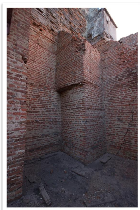
Ryc.3.47 C Fragment ściany północnej przewiązany z murem kurtynowym przy murze N, widok od SE D Nadbudowana przypora wewnętrzna muru południowego, widok od NE (fot. P. Muntowski)
