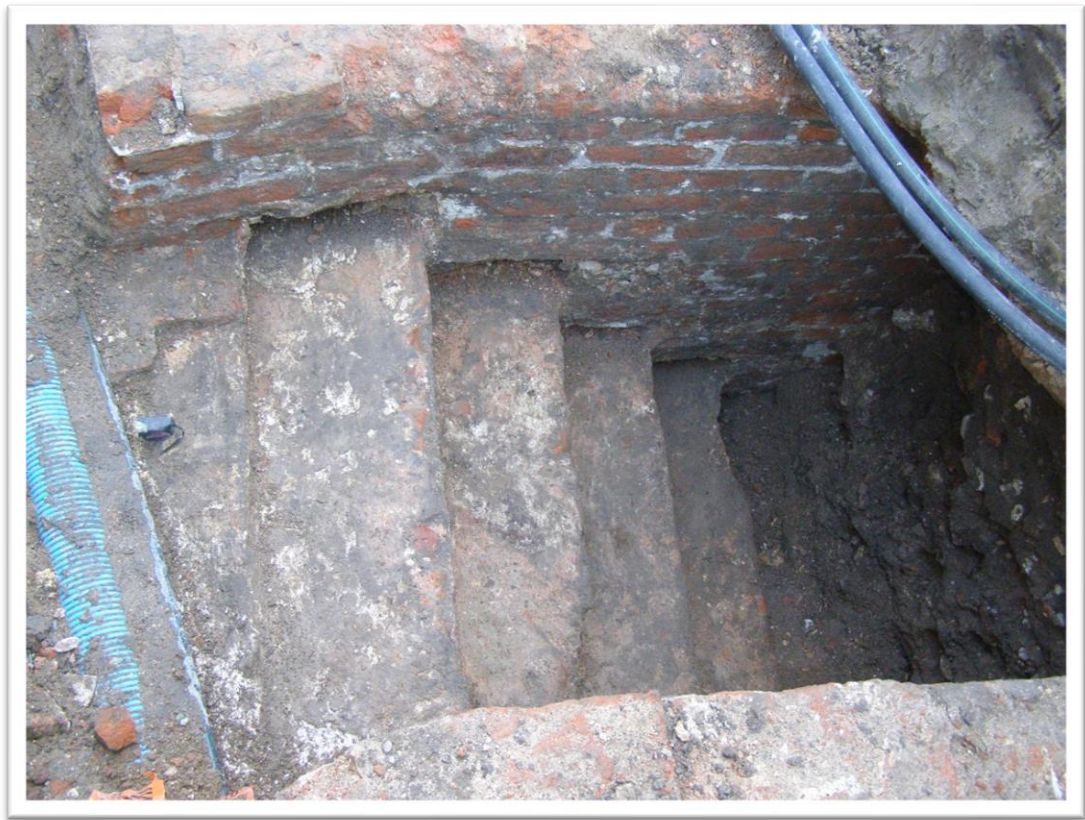
Ryc.4.30 Schody w grubości muru południowego dziedzińca. Widok od S (fot. M. Kasprzak)
