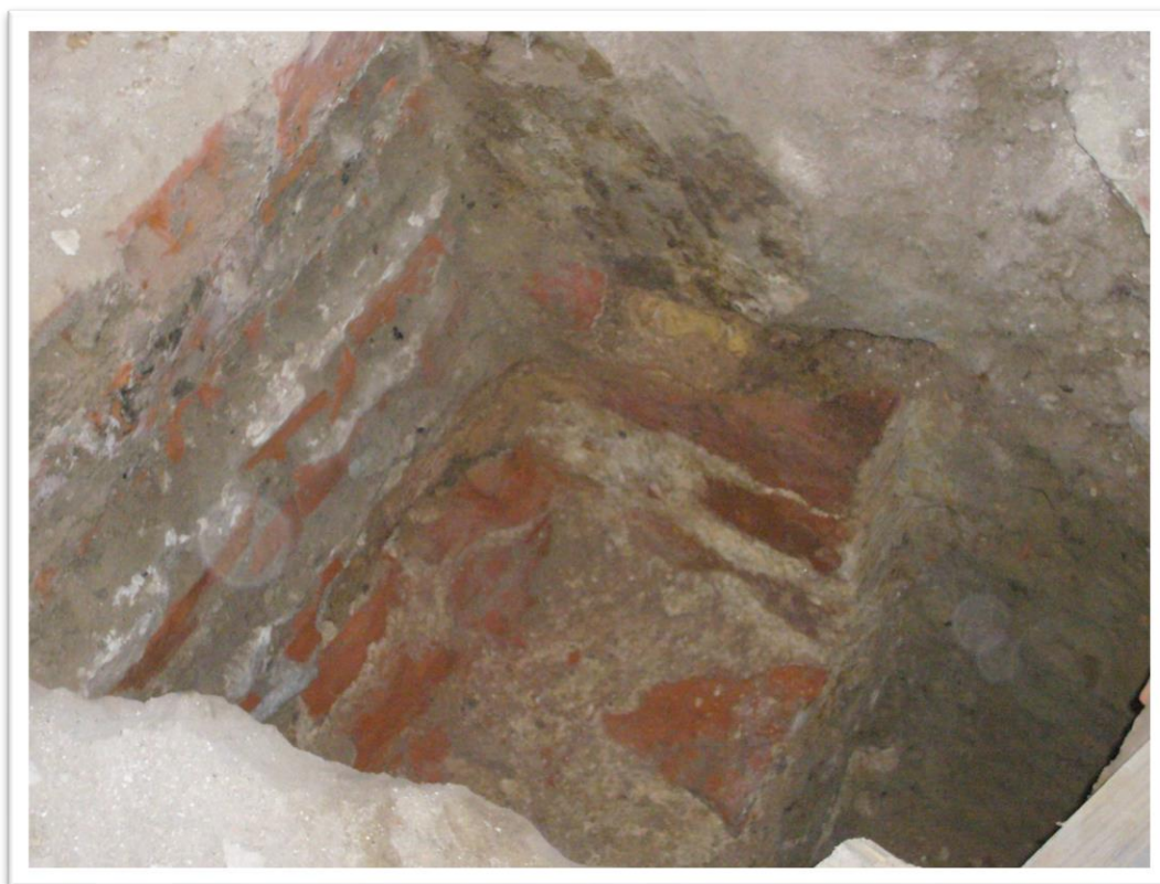
Ryc.4.51 Widok na klatkę schodową prowadzącą do piwnicy przebite nad pomieszczeniem p1 w XIX wieku. Widok od S (fot. M. Kasprzak)
