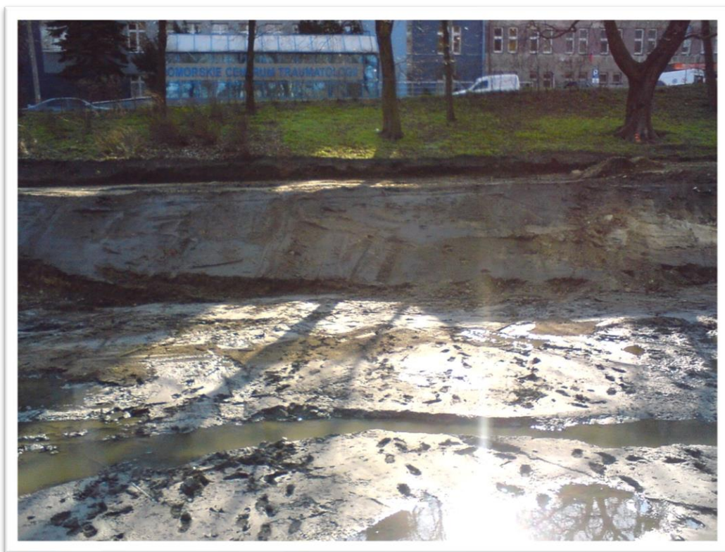
Ryc.5.12 Pozostałości fosy mokrej u stóp Bastionu Neubauera w trakcie prac rewitalizacyjnych. Widok od W (fot. M. Kasprzak)
