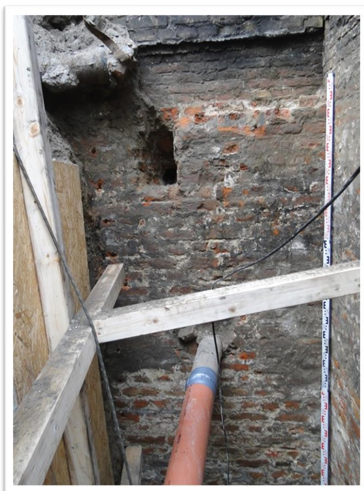
Ryc.3.55 A Fragment ściany gotyckiej kamienicy wraz z przedprożem, na której posadowiono ścianę wschodnią Wielkiej Zbrojowni. Odcinek północny. Widok od E
