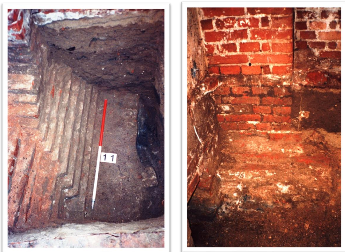
Ryc.6.54 Sondaż 2 i 4 A. Fundament schodkowy pod filar w centralnej części Bastionu Artyleryjskiego. Widok od S (sondaż 4), B. Fundament filaru przyściennego. Widok od N (sondaż 2) (fot. A. Pudło)
