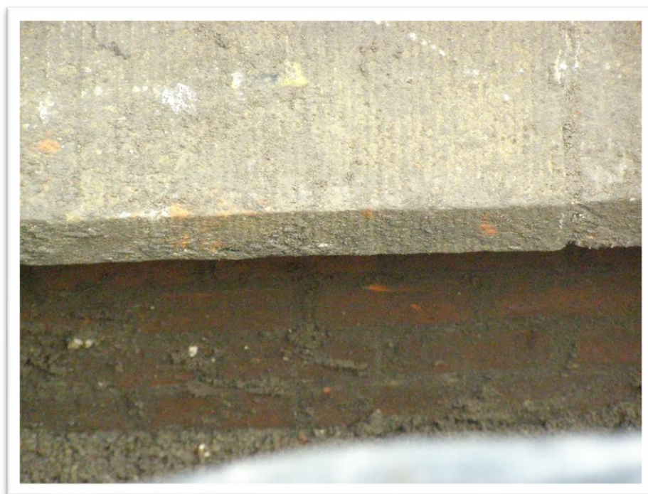
Ryc.4.35 Sondaż 1 z 2010 roku. Zbliżenie na fragment ceglanej elewacji ściany zachodniej wykonana w drugiej połowie XIX wieku. Widok od W (fot. M. Kasprzak)
