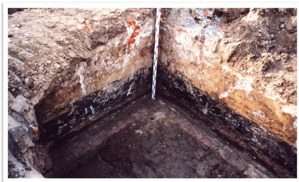
Ryc.6.72 Narożnik SW XVIII wiecznego budynku z zachowanym tynkiem i farbą fluorescencyjną pokrywających dolną część ścian. Widok od NE (fot. M. Kasprzak)
