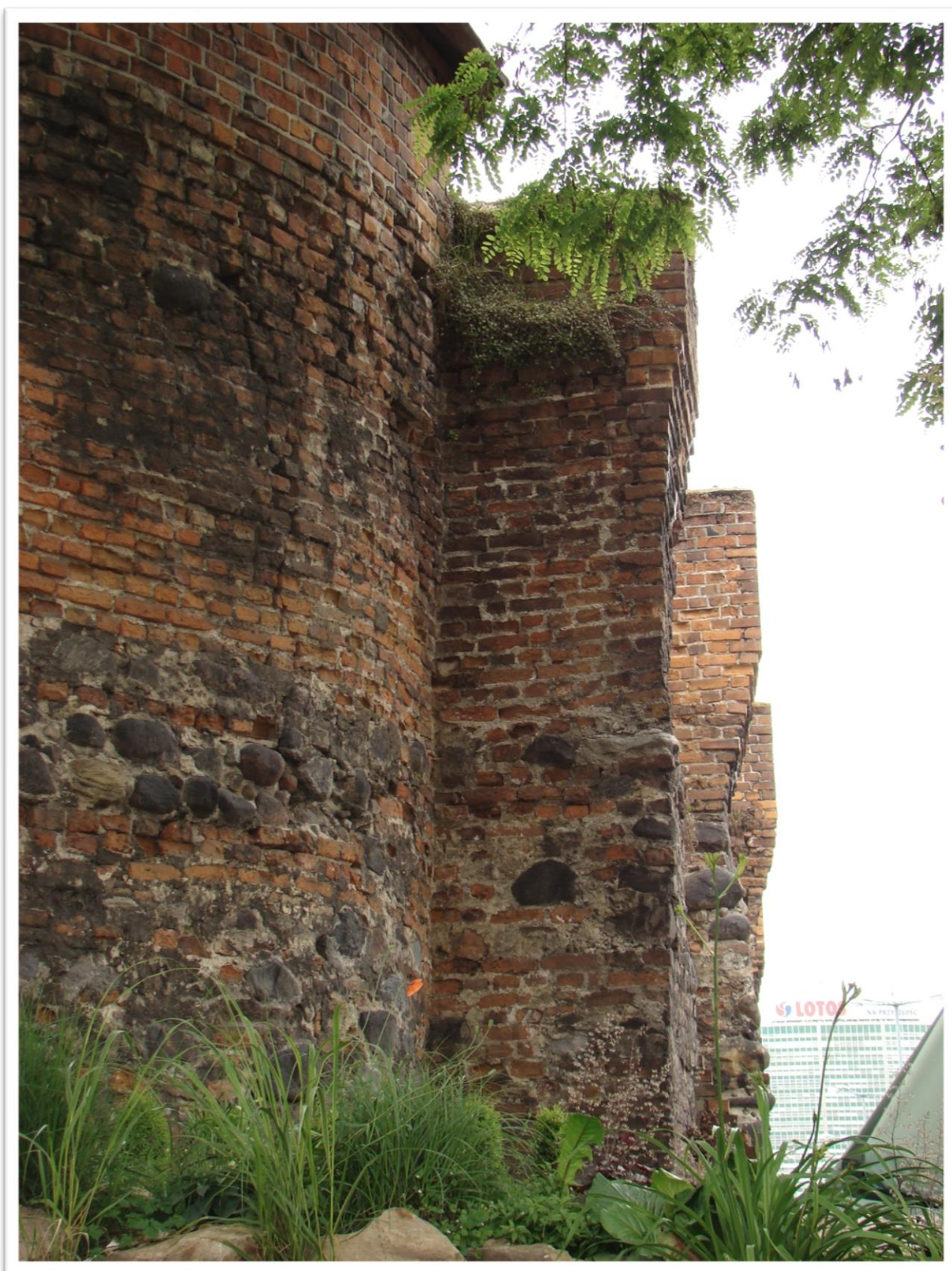
Ryc.3.10 Ściana wschodnia bastei z przyporami. Widok od S (fot. P. Matuszewski)
