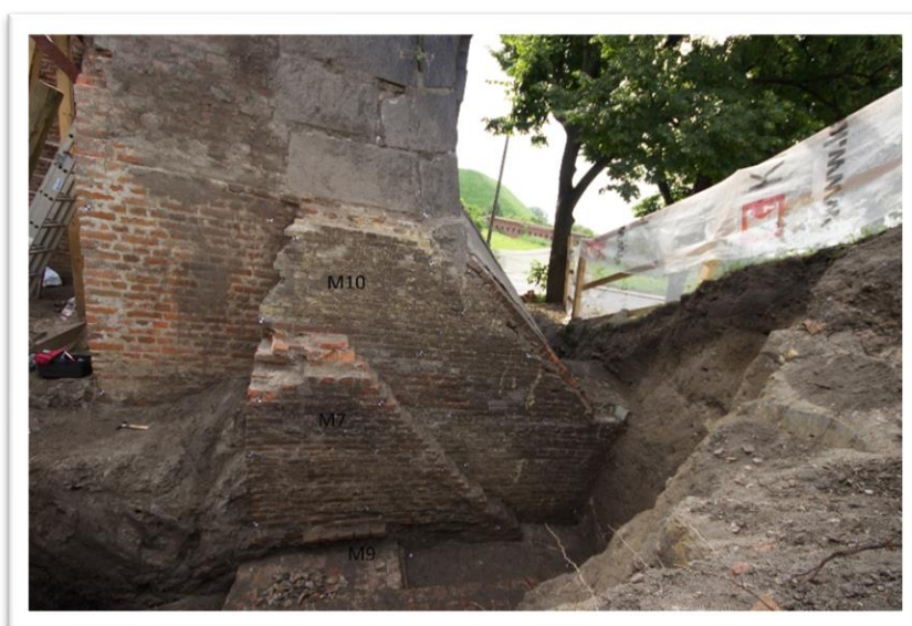
Ryc.3.46 Zachodnia przypora zewnętrzną z murem oporowym z nadbudową (mur 7,9,10). Widok od W (fot. P. Muntowski)
