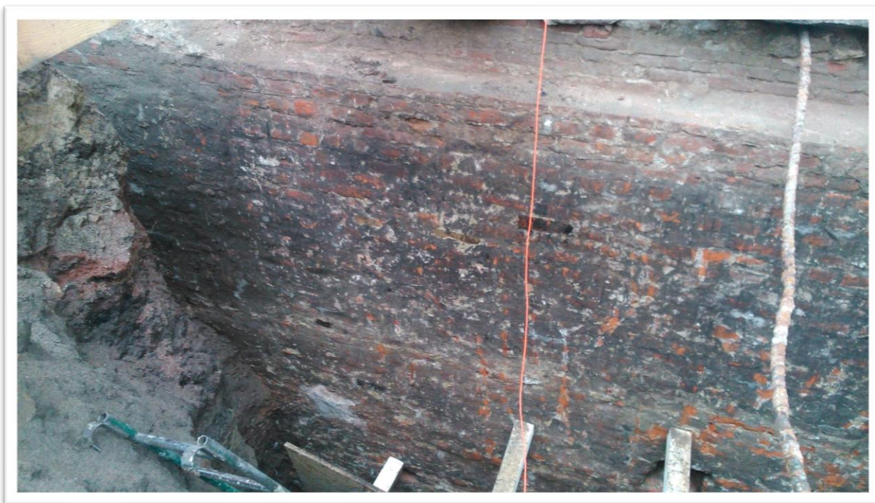
Ryc.3.53 Fragment ściany gotyckiej kamienicy na, której posadowiono ścianę wschodnią Wielkiej Zbrojowni. Odcinek pomiędzy basztami. Widok od NE (fot. P. Muntowski)
