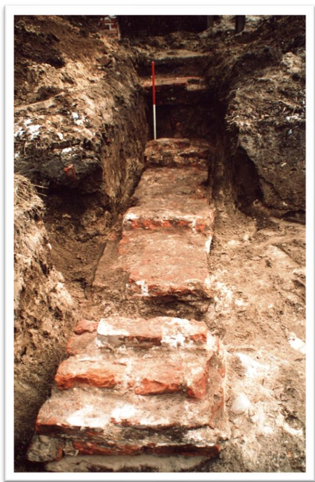
Ryc.6.37 C - część wschodnia ściany południowej Domu Porucznika Piechoty. Widok od W (fot. M. Kasprzak)
