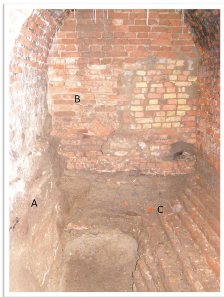
Ryc.4.15 A Nawarstwienia ziemne powstałe w trakcie budowy bramy, B. zamurowane sklepienie w ścianie wschodniej piwnicy z otworami na rury wodociągowe, C. fragment fundamentu schodkowego południowej ściany piwnicy. Widok od W (fot. i oprac. M. Kasprzak)
