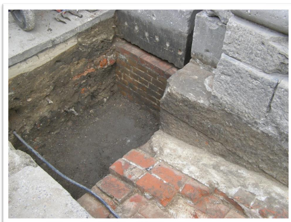
Ryc.4.39 Zbliżenie na północno – wschodni fragment elewacji północnej posadowionej na ceglanym fundamencie. Widok od NW (fot. M. Kasprzak)
