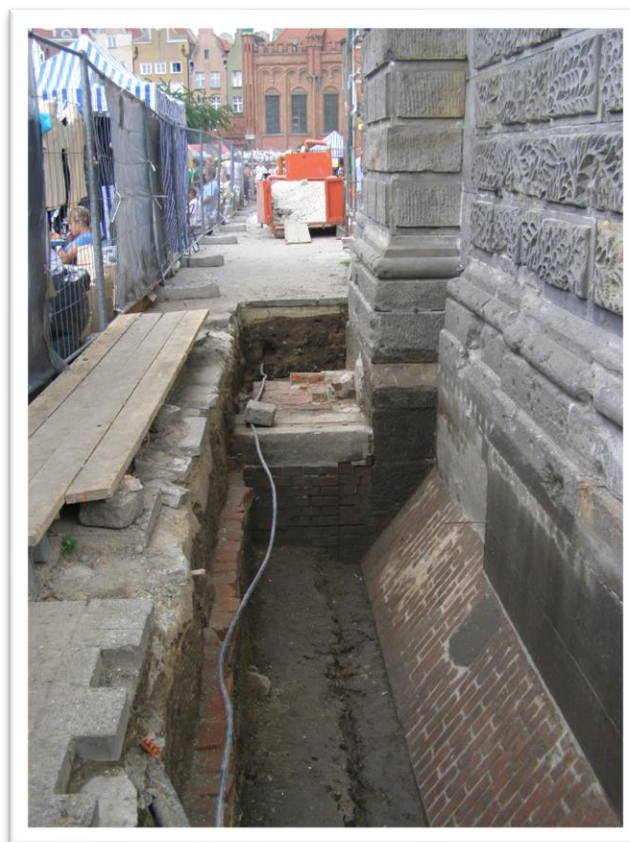
Ryc.4.37 Sondaż 1 z 2010 roku. Widok na dolną część kamiennej elewacji północnej wraz z oskarpowaniem. W głębi widoczny pilaster przejazdu wybitego w wale ustawiony na ceglany fundamencie oraz kamienny próg w przejeździe wsparty również na ceglany fundamencie. Widok od W (fot. M. Kasprzak)
