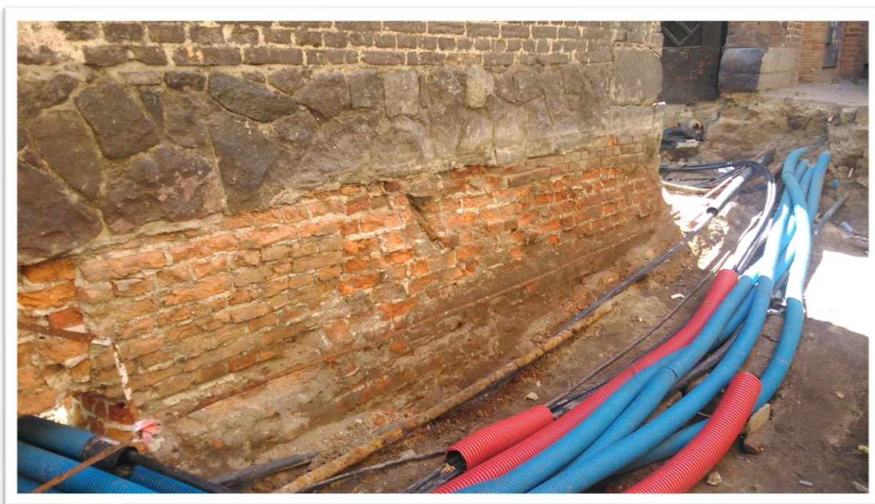
Ryc.3.58 A Część południowa lica zachodniego muru niskiego na, której postawiono ścianę frontową Starej Apteki. Widok od NW
