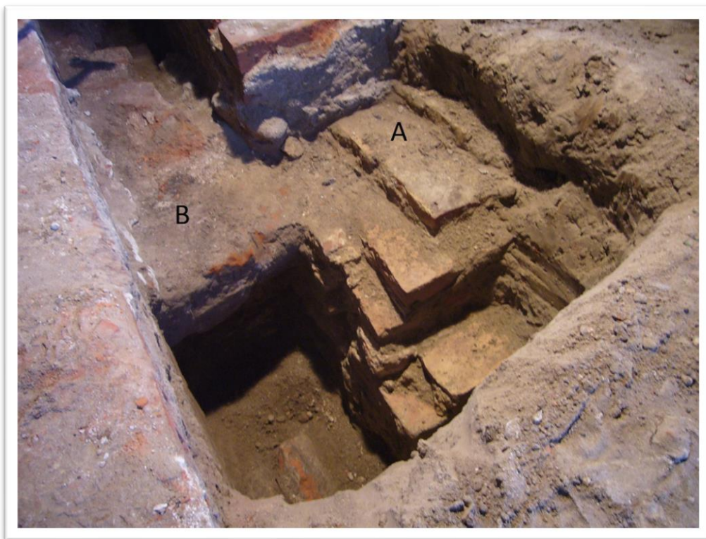
Ryc.4.57 A Zbliżenie na S –E narożnik konstrukcji starszego mostu. B fragment najstarszego muru zanotowanego podczas nadzorów z zalegającym na nim murze z cegły dziurawki. Widok od E (fot. i oprac. M. Kasprzak)
