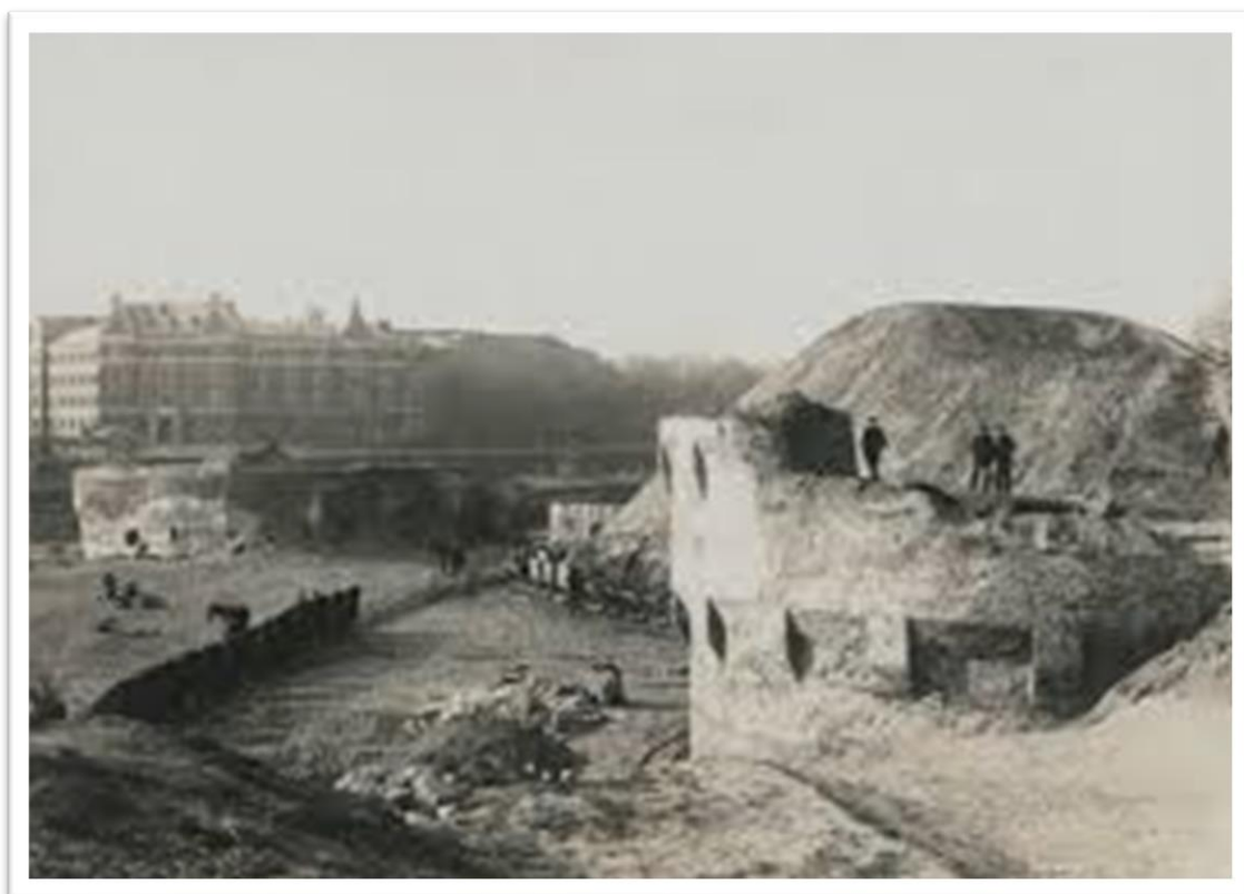
Ryc.3.6 Bastion św. Elżbiety w trakcie rozbiórki na początku XX wieku. W głębi fotografii XVI wieczna podkowiasta konstrukcja użytkowana jako magazyn prochowy (Tusk, Duda, Fortuna, Nawrocki 1996, s.14)
