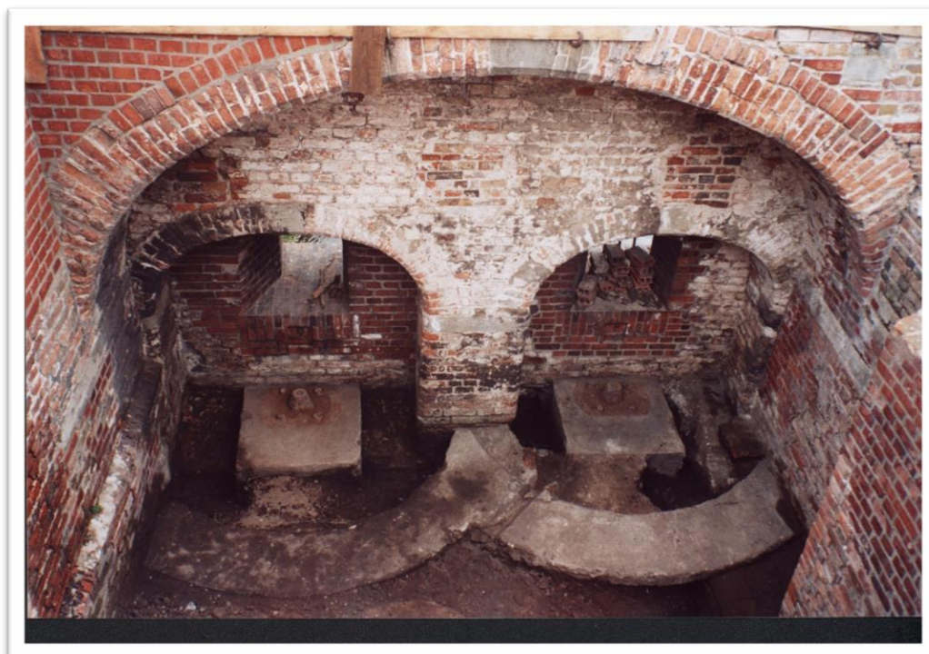
Ryc.6.55 Bastion Artyleryjski A. Widok od N na podstawy dział zamontowanych w uchu bastionu w latach 70tych XIX wieku
