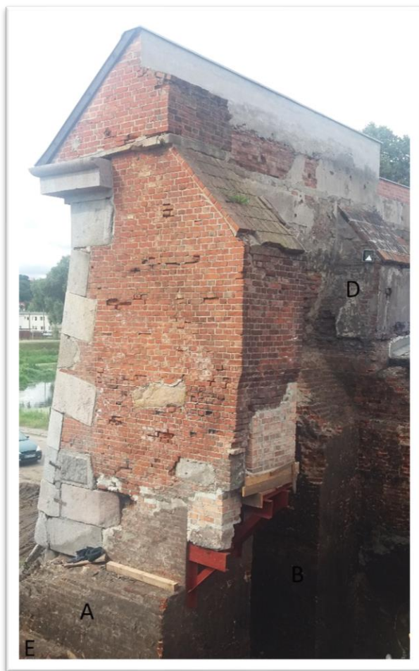
Ryc.3.45 Widok ogólny na wschodnią część ściany południowej. A przypora zewnętrzna z odsadzką, B przypora wewnętrzna, C nadbudowa przypory zewnętrznej, D przypora nadbudowana na ścianie wschodniej budynku bramnego, E przypora poprzeczna wspierająca kamienną elewację, widok od NW (fot. P. Muntowski)
