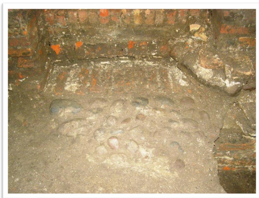
Ryc.4.19 Widok na północno – wschodni narożnik piwnicy. Po prawej widoczny najstarszy poziom schodów wykonanych w grubości ściany północnej (fot. M. Kasprzak)
