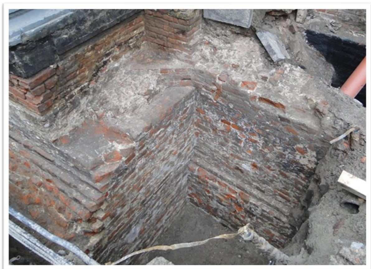
Ryc.3.54 A Fragment przedproża gotyckiej kamienicy na, którym posadowiono północną basztę Wielkiej Zbrojowni. Widok od NE
