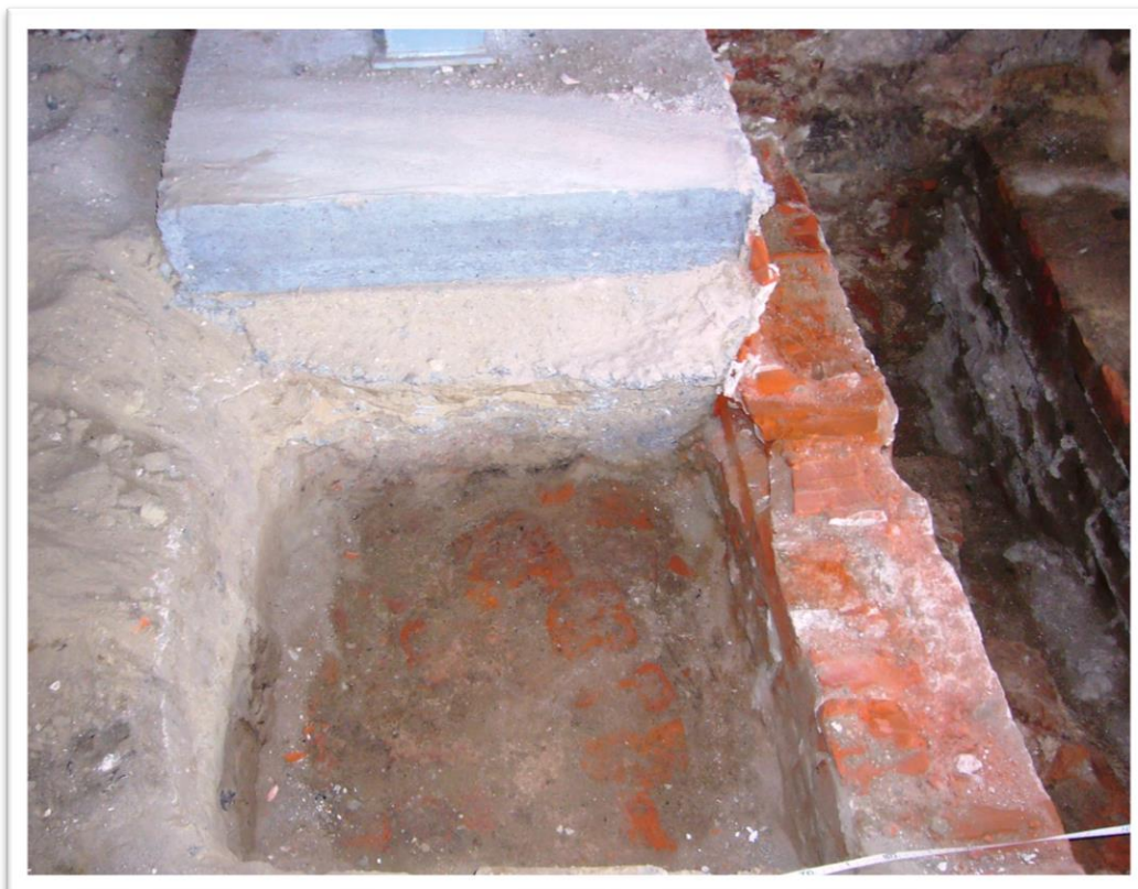
Ryc.4.58 Widok na południową część korony XVI wiecznego muru. Widok od E (fot. M. Kasprzak)
