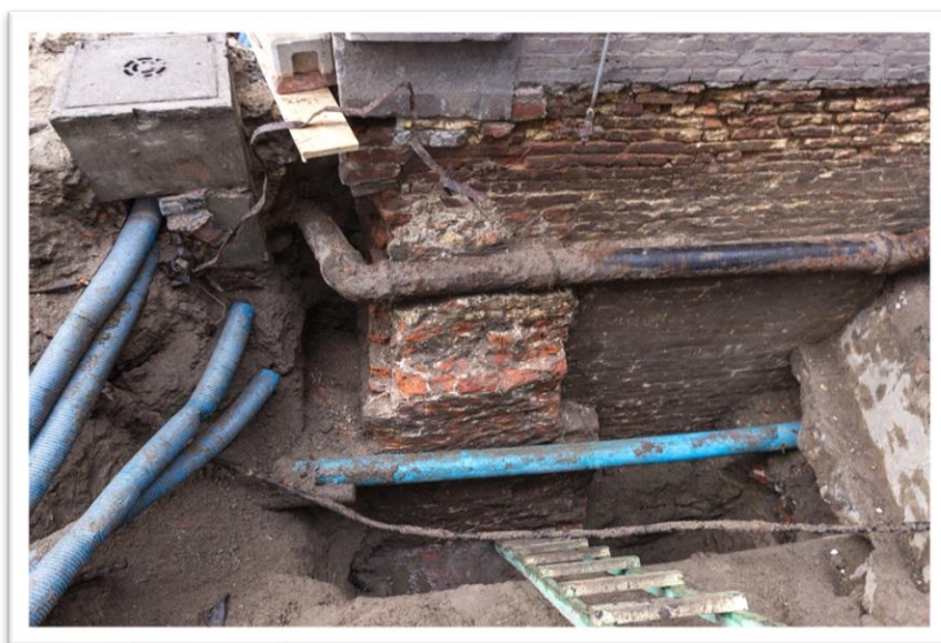
Ryc.3.51 C. Południowo- zachodni narożnik Wielkiej Zbrojowni. Widok od S (fot. P. Muntowski)
