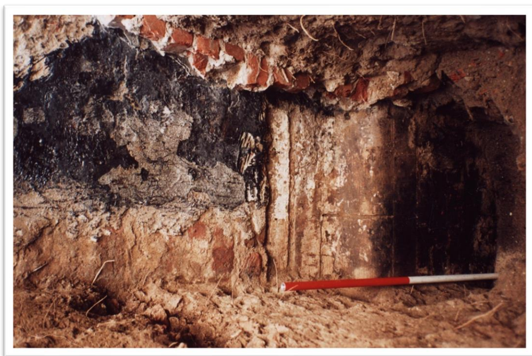
Ryc.6.13 Zamurowane wejście do Wieńca od strony kurtyny zachodniej powstałe po usypaniu wału w tej części Fortu Carre. Zamurowane po podniesieniu poziomym nasypów w końcu XVIII bądź na początku XIX wieku A widok całości, B zbliżenie na fragment progu). Widok od W (fot. M. Kasprzak)
