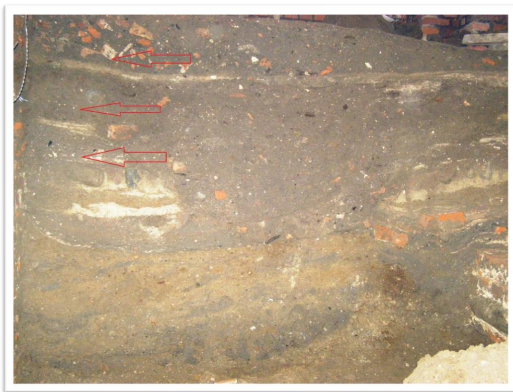
Ryc.4.24 Przekrój przez nawarstwienia ziemne w północnej części piwnicy. Strzałkami oznaczono pozostałości poziomów użytkowych. Widok od S (fot. i oprac. M. Kasprzak)
