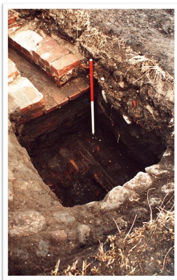
Ryc.6.62 Kanalizacja burzowa z lat 70 tych XIX wieku. A. Zbliżenie na odcinek przebiegający wzdłuż Domków Oficerskich - ceglany kanał przykryty dwuspadowym daszkiem wykonanym z cegieł, B. odcinek kanału biegnący wzdłuż podjazdu północnego przykryty płaskim daszkiem wykonanym z płaskich cegieł,
