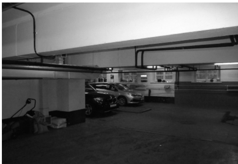
Fot. 3. Piwnice – konstrukcja wspierająca układ bocznych korytarzy na kondygnacjach naziemnych, A. Barczyk
