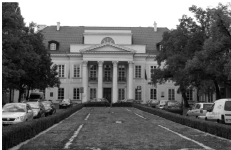
Fot. 2. Fasada pałacu Mniszchów – stan obecny, A. Barczyk
