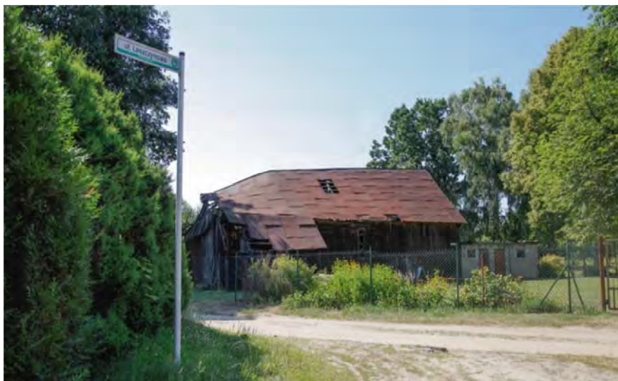
Fot. 18. Destrukcja zabudowy zagrodowej we wsi Babiczki (gmina Lutomiersk)
