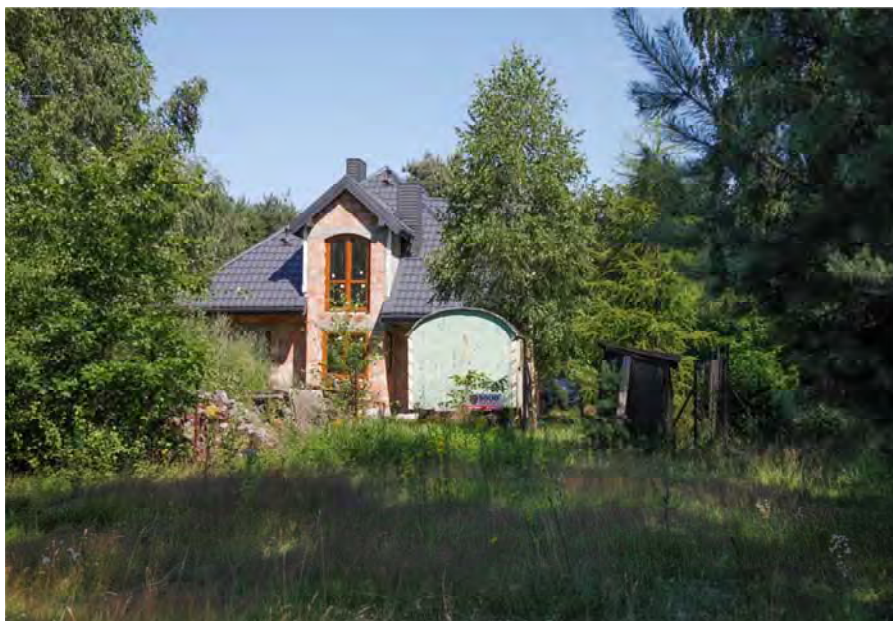
Fot. 45. Etap zaawansowanej budowy obiektu rezydencjalnego (teren dawnej działki rekreacyjnej) we wsi Babiczki (gmina Lutomiersk) Autor: M. Kossowski
