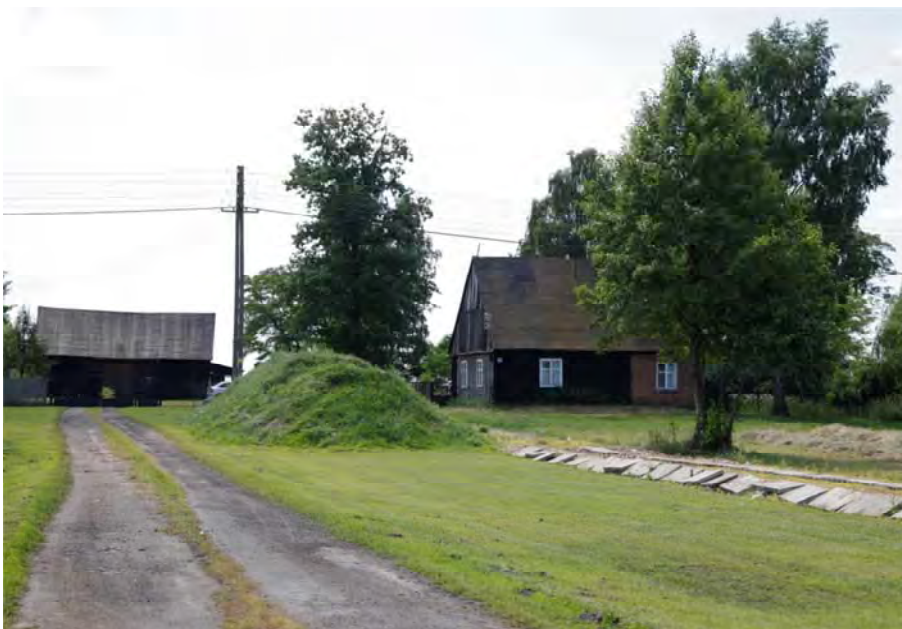
Fot. 20. Degradujące się budownictwo zagrodowe we wsi Dobroń Mały (gmina Dobroń)
