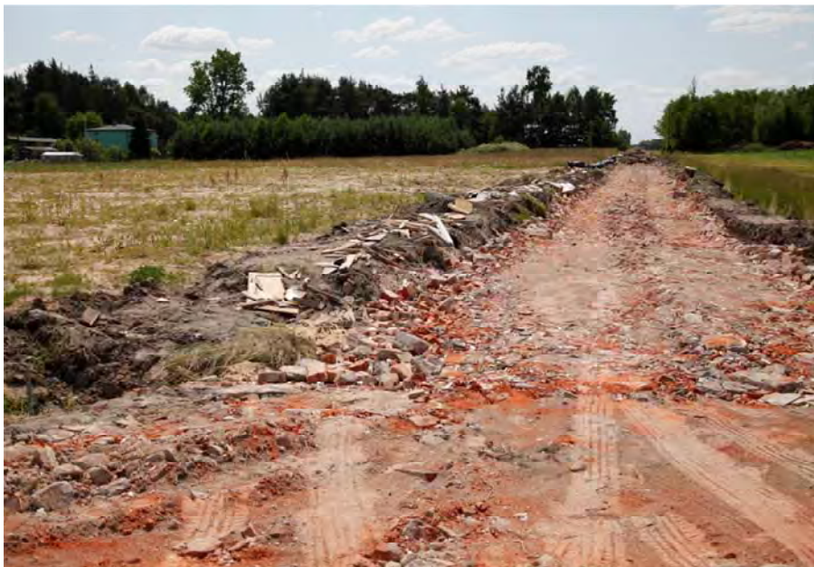
Fot. 43. Utwardzanie drogi gruntowej gruzem. Przygotowania do budowy kompleksu nowej zabudowy mieszkaniowej. Gmina Dobroń. Autor: M. Kossowski
