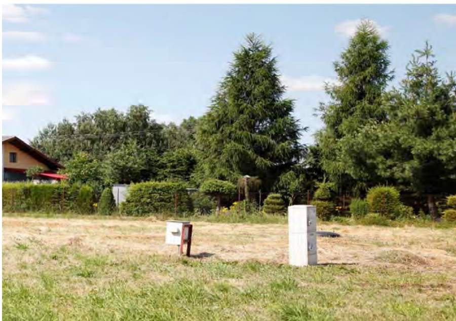
Fot. 41. Przyłącze energetyczne. Przygotowania do realizacji inwestycji we wsi Hermanów (gmina Pabianice) Autor: M. Kossowski
