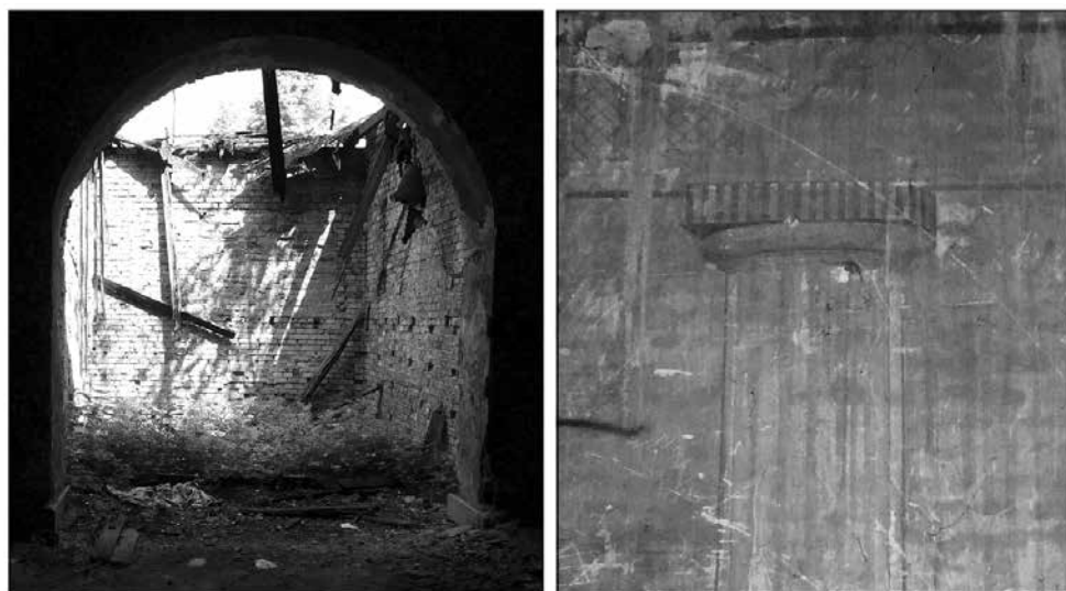
Wnętrze domu przedpogrzebowego cmentarza żydowskiego w Katowicach (z lewej – sukcesja roślinności w zdewastowanej przestrzeni, z prawej – fragment ściennych polichromii). Fot. Anna Majewska
