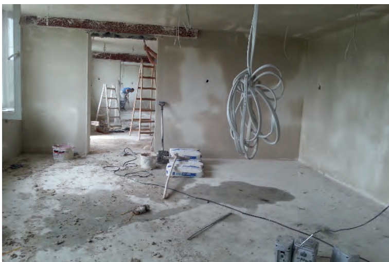
Fot. 53. Sala grupy III podczas remontu, 2015
