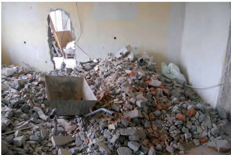
Fot. 52. Prace remontowe, 2015
