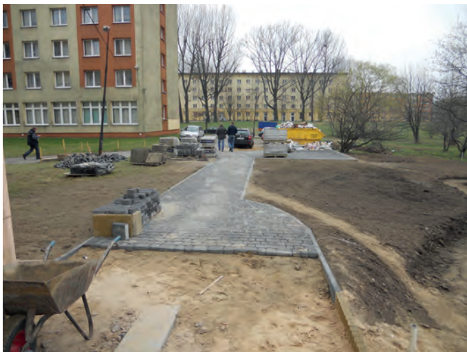
Fot. 3. Wejście do budynku przedszkola, 2012
