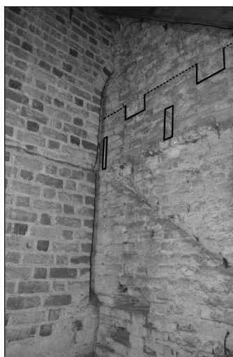
Ryc. 18. Szadek, kościół parafialny, płn. elewacja korpusu, trzecie przęsło od wsch. – sytuacja widoczna na poddaszu kaplicy. Zach. ściana kaplicy dostawiona do zamurowanego okna w korpusie. W obu ścianach bruzdy po połaci dawnego dachu pogrążonego. W zach. ścianie kaplicy, nad nieznacznie wysuniętą półką, zarysy krenelażowej attyki z otworami szczelinowymi
