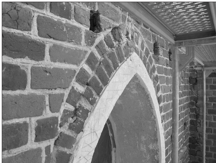
Ryc. 4. Szadek, kościół parafialny, prezbiterium, ostrolukowe zamknięcie jednego z okien. Wysklepek wykonany z cegły maszynowej. Nad nim grzbiet pierwotnego łuku z cegły palcowanej
