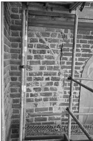
Ryc. 10. Szadek, kościół parafialny, przypora korpusu widoczna we wsch. elewacji kaplicy Matki Bożej Różańcowej. W ścianie przypory ukośnie schodząca linia – zamknięcie pierwotnej wysokości; wyżej nadbudowana część przypory
