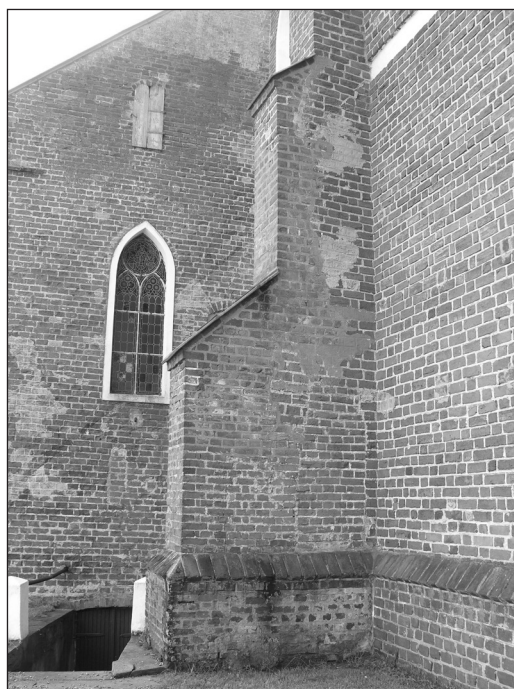
Ryc. 24. Szadek, kościół parafialny, zach. elewacja kaplicy Matki Bożej Różańcowej i przedostatnia przypora korpusu kościoła. W jej ścianie zach. zarys zamurowanego wejścia na piętro kaplicy. Stan przed konserwacją
