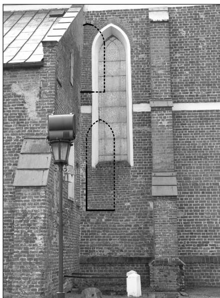
Ryc. 14. Szadek, kościół parafialny, płn. elewacja korpusu, fragment trzeciego przęsła od wsch. z wtórnym oknem. Pod parapetem, przy narożniku ze ścianą kaplicy, glif i parapet pierwotnego otworu. Wyżej relikty następnego okna. Stan przed konserwacją Źródło: fot. Łukasz Holcer, 2009
