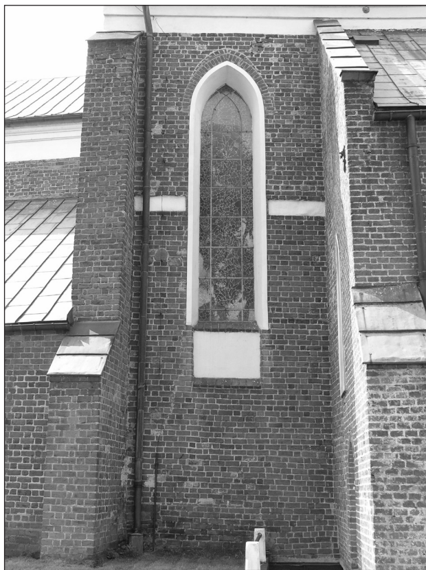
Ryc. 9. Szadek, kościół parafialny, płn. elewacja korpusu, okno w pierwszym przęśle od wsch. Wokół otynkowanej wnęki pod parapetem cegła maszynowa. Nad ostrołukowym zamknięciem grzbiet pierwotnego łuku. W połowie wysokości ściany pas wgłębnego fryzu. Stan przed konserwacją
