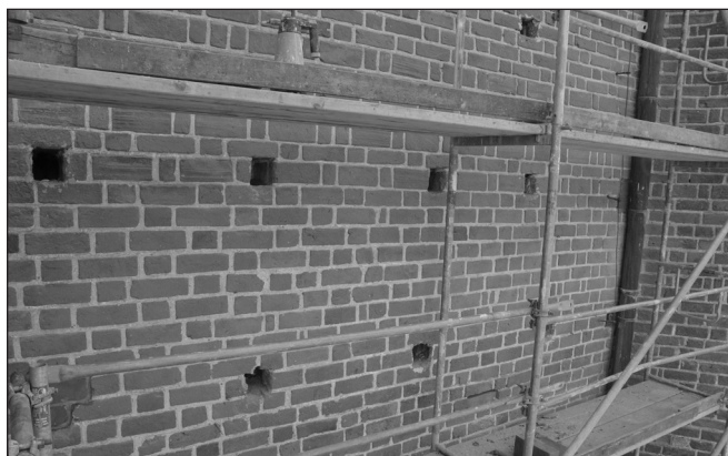
Ryc. 8. Szadek, kościół parafialny, płn. elewacja korpusu, czwarte przęsło od wsch., część dolna. W gotyckim wątku ściany regularnie rozstawione otwory maczulcowe Źródło: fot. Łukasz Holcer, 2014
