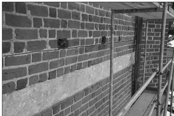
Ryc. 12. Szadek, kościół parafialny, płn. elewacja korpusu, czwarte przeszło od wsch. Lico ściany na całej wysokości opracowane w wątku gotyckim. Powyżej trzech warstw nad otynkowanym tłem wgłębnego fryzu czytelna linia nadbudowy – inna cegła i zaprawa
