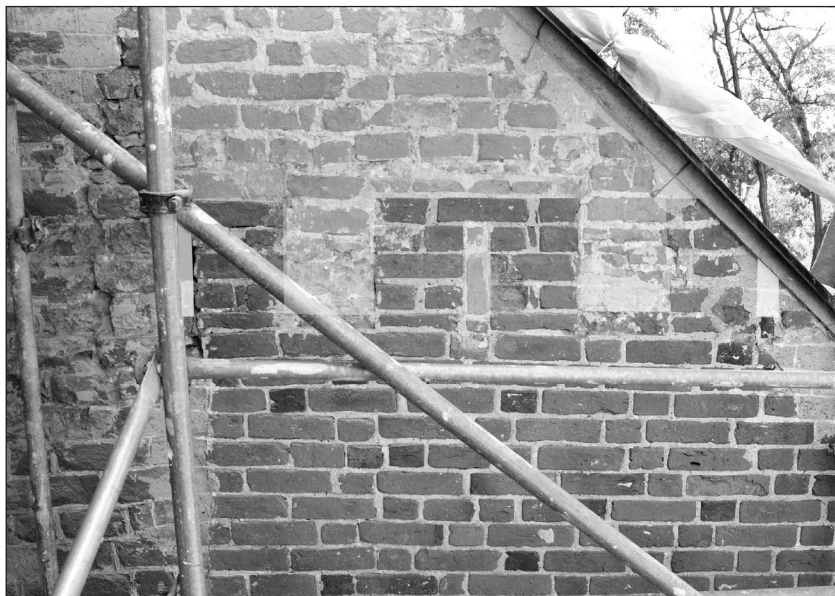
Ryc. 25. Szadek, kościół parafialny, górna partia wsch. elewacji kaplicy Matki Bożej Różańcowej. Zarysy dawnej attyki w formie krenelaża z otworami szczelinowymi. Wyżej późniejsza nadbudowa z wykorzystaniem materiału rozbiórkowego
