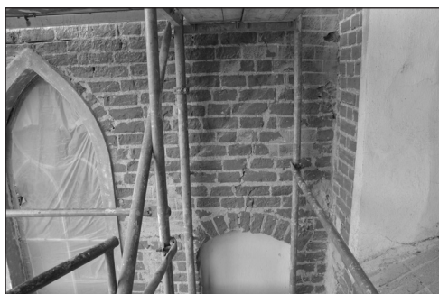
Ryc. 23. Szadek, kościół parafialny, zach. elewacja kaplicy Matki Bożej Różańcowej. Nad zamurowanym i wysoko usytuowanym wejściem ukośna bruzda – ślad po dawnym zadaszeniu. Przy ostrołukowym oknie fragment grzbietu pierwotnego łuku o przebiegu półkolistym
