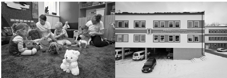
Fot. 3–4. Rozbudowa Ośrodka Rehabilitacyjnego w Wolbromiu
